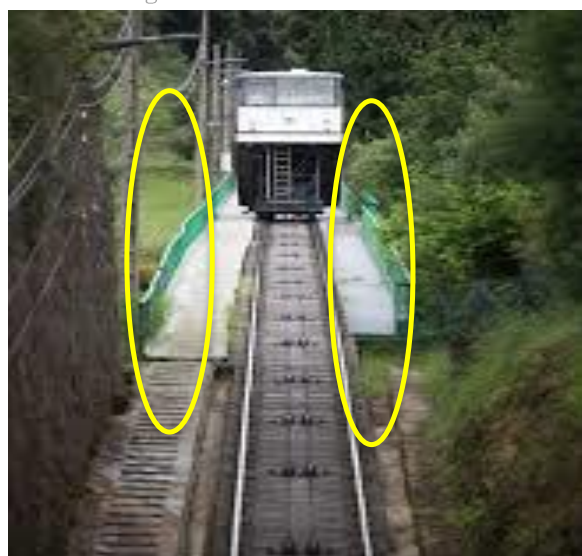
Imagen del tramo inter-estaciones
