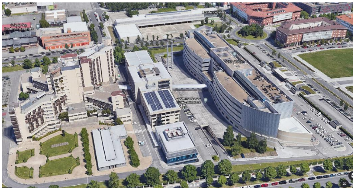
Vista complejo de Lakua
