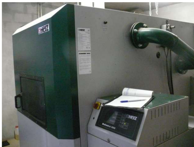
Caldera HERZ modelo BIOMATIC 500 BIOCONTROL
