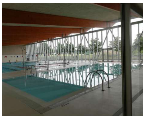
Interior recinto piscina
