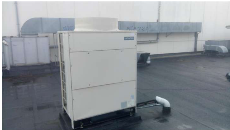
Unidad exterior HITACHI modelo RAS FSN 16
