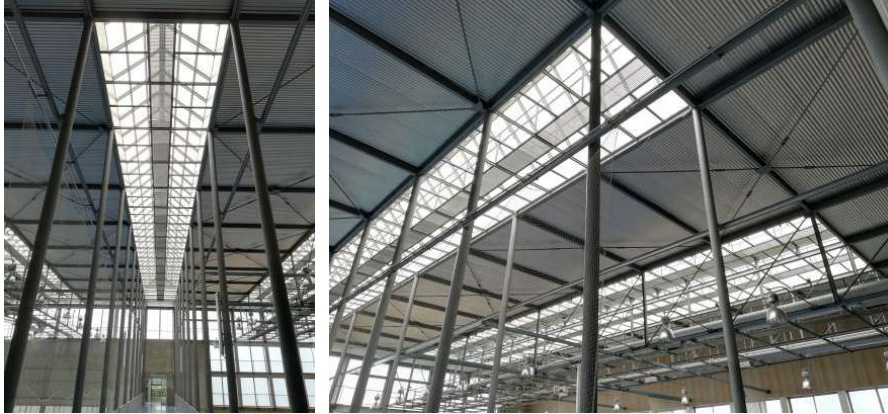
Imágenes interiores de la cubierta de chapa y lucernarios
