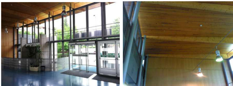
Imagen del vestíbulo y detalle interior de la cubierta de madera.
