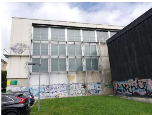
Carpintería fachada sureste
