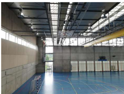
Carpintería fachada noreste y sureste
