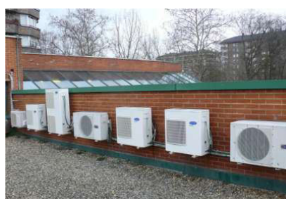
Imágenes de las unidades exteriores en cubierta
