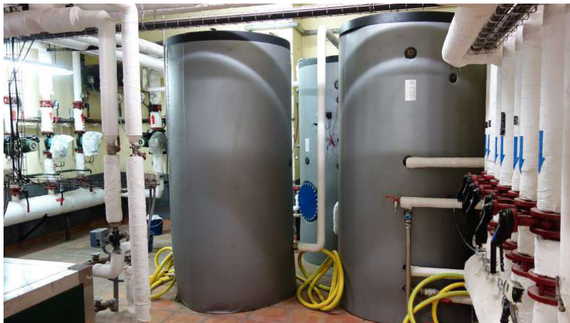
Imagen de los depósitos de acumulación
