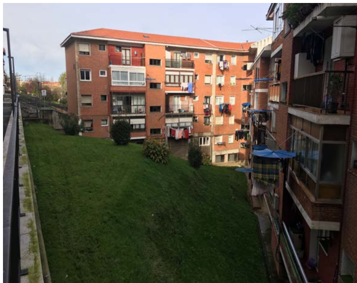
Taludes en zona cerrada (interior – manzana)
