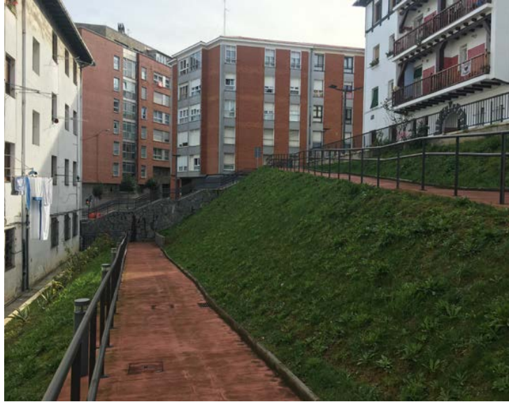
Taludes en zona abierta
