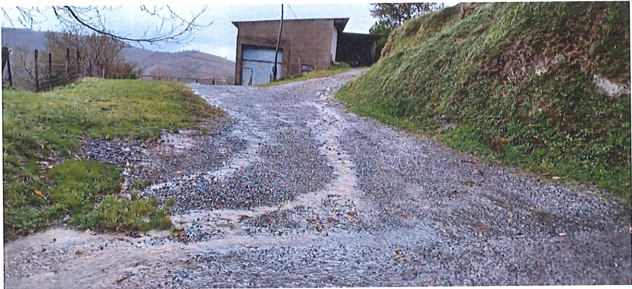
Ilustración 6: Detalle de la zona de obra.
