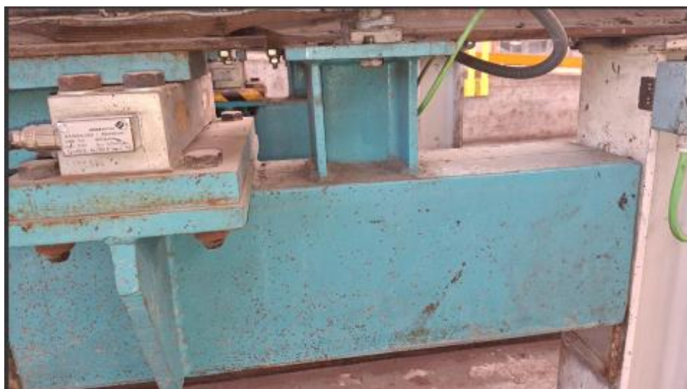
Foto 5. Detalles de unión de la viga soporte.
