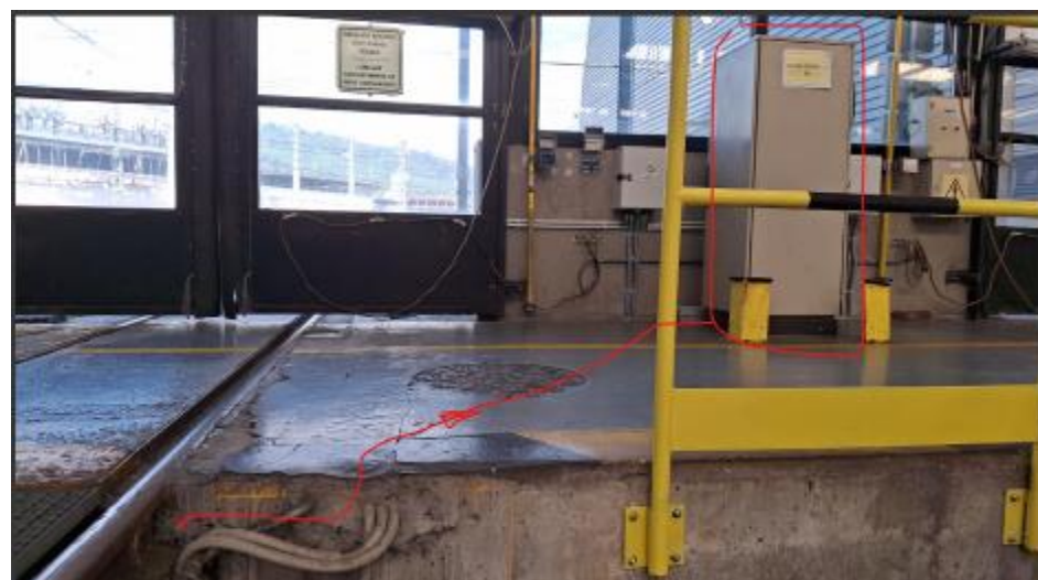
Foto 7. Rutado cableado interconexión equipos de campo y armario eléctrico.
