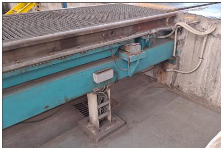
Foto 6. Apoyo de la viga soporte y ubicación caja suma.
