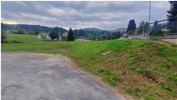
Foto 6. Talud con carretera
