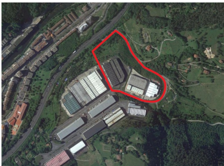
Foto 1.-Contorno del Antiguo vertedero de Urruzuno. Polígono industrial de Albitzuri,
