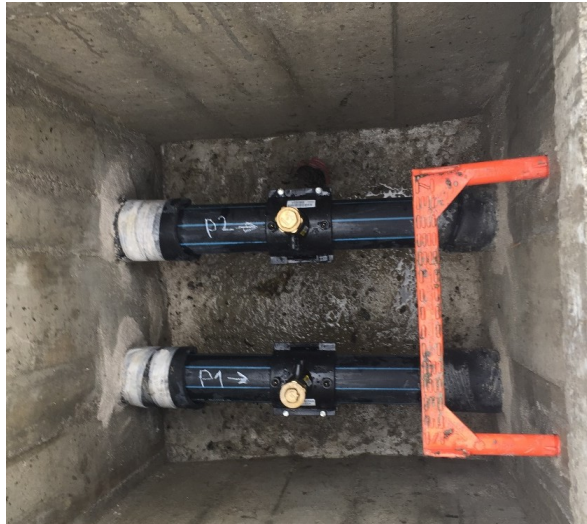
Foto 02: Secciones de control de los pozos 1 y 2.
