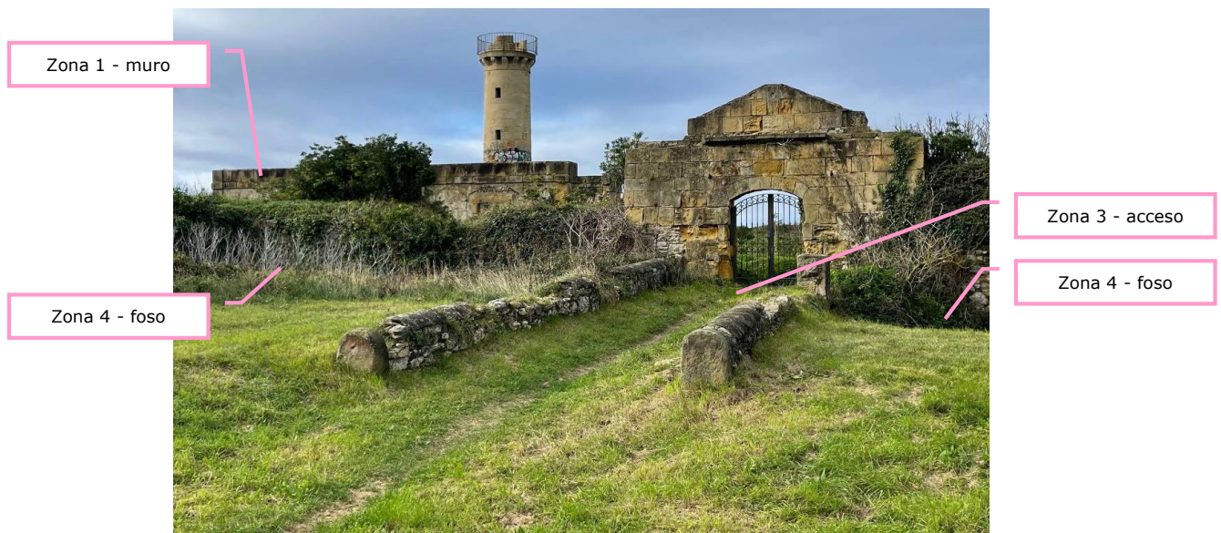
Figura 1. Vista del acceso, foso sur y muro perimetral sur del Fuerte y Faro de La Galea
