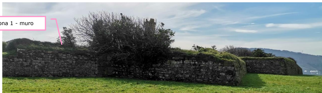
Figura 3. Vista de muro perimetral norte del Fuerte y Faro de La Galea
