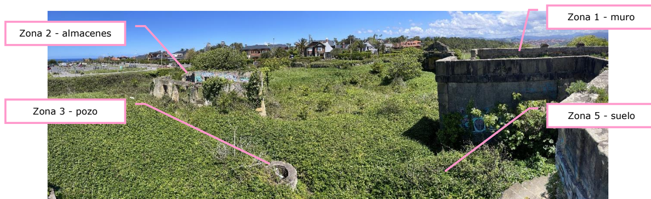
Figura 4. Vista interior del Fuerte y Faro de la Galea, desde baluarte sur
