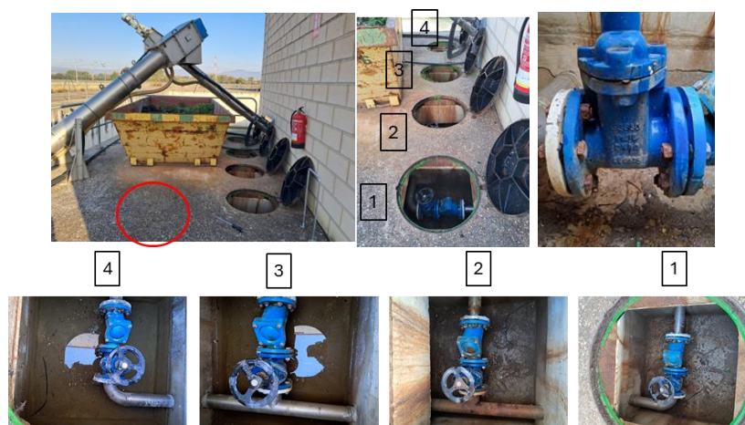
Figura 9 Vistas de la EBAR. (Izq-Centro): Arquetas de válvulas existentes (1-4) que no son objeto de la actuación. (Arriba Der y abajo): Ubicación aproximada (círculo rojo) para la ejecución de la nueva arqueta de medición sobre la impulsión común enterrada. Ubicación: PUNTO 10 - EBAR JUNDIZ.
