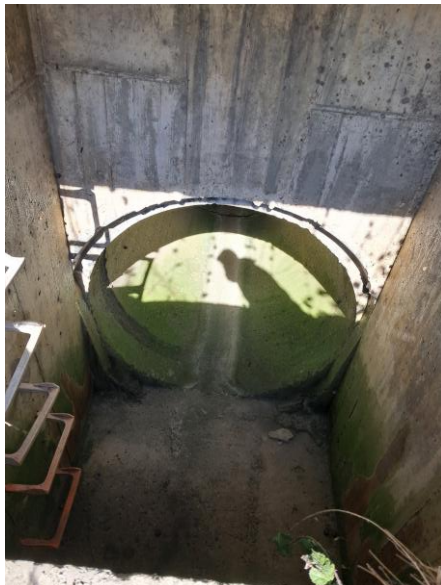
Figura 4 Interior del colector de hormigón circular de 1500 mm y emplazamiento para armario con acometida eléctrica (aprox. 10-15m). Ubicación: PUNTO 4 - RÍO MENDIGORRITXU.
