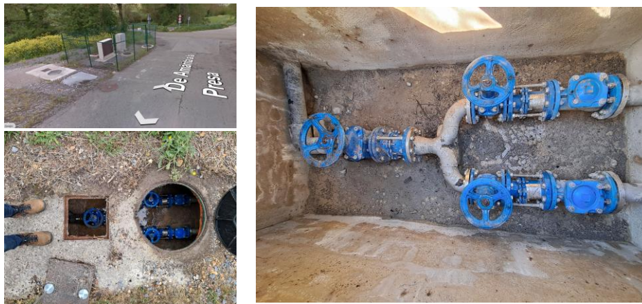
Figura 8 Arqueta de calderería (aprox. 240x140 cm) existente y entorno. Ubicación: PUNTO 8 – EDAR AMARITA.
