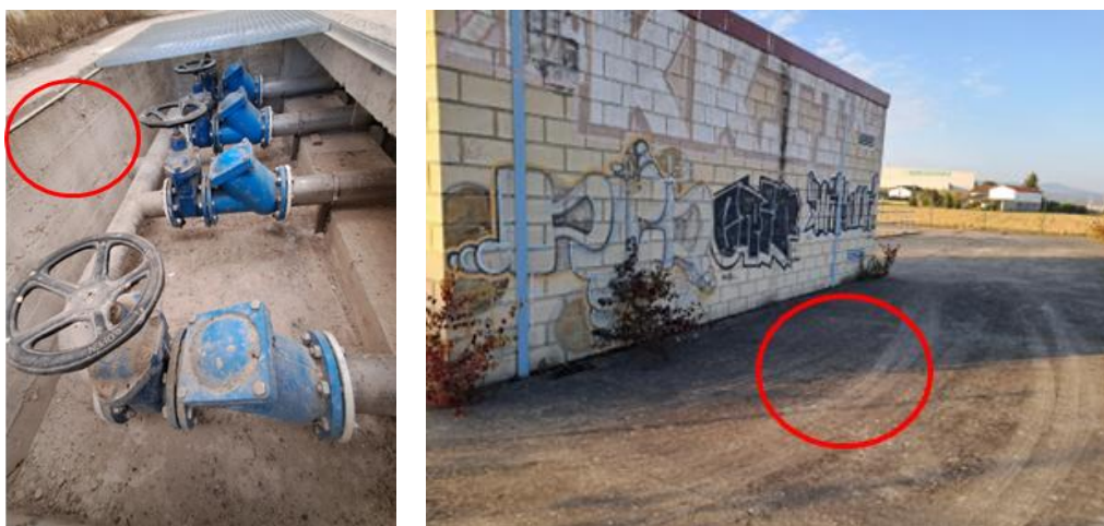
Figura 10 Vistas de la EBAP DN150. (Izq): Arqueta interior de válvulas, sin espacio para caudalímetro. (Der): Zona exterior (círculo rojo) propuesta para la ejecución de la nueva arqueta de medición. Ubicación: PUNTO 11 - EBAP JUNDIZ (DN150).
