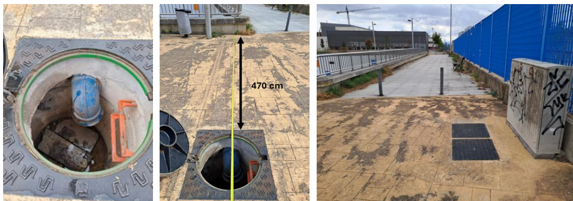
Figura 11 Vistas de la EBAP Salburua. (Izq): Pozo de rotura en carga con tubería DN200. (Centro): Zona exterior propuesta para la nueva arqueta. (Der): Armario eléctrico existente. Ubicación: PUNTO 12 - EBAP SALBURUA.
