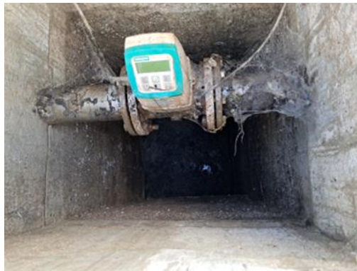
Figura 13 Vistas de la actuación. (Izq./Der.): Arqueta de medición y caseta de control anexa (aprox. 10–15 m) para el transmisor remoto. Ubicación: PUNTO 18 - EBAR ASTEGUIETA.
