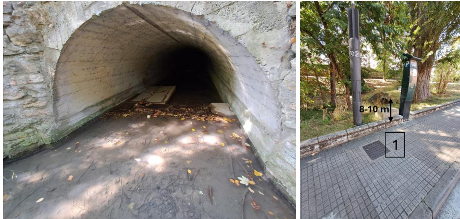
Figura 1 Interior del colector abovedado (3000x1800mm). Arqueta/punto de conexión eléctrica existente en acera (marcada "1") y farola junto al emplazamiento previsto del armario.
