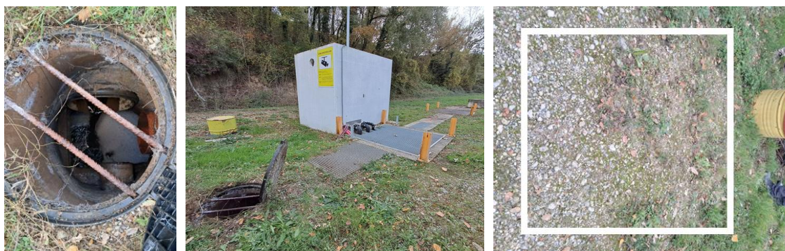
Figura 6 Vistas de la zona de actuación. (Izq): arqueta de unificación existente. (Centro/Der): Caseta de control anexa y zona propuesta para el nuevo arquetón (ejecución por tercero en contrato independiente, no incluido en este pliego). Ubicación: PUNTO 7 - RÍO ZAPARDIEL / GARDELEGI.
