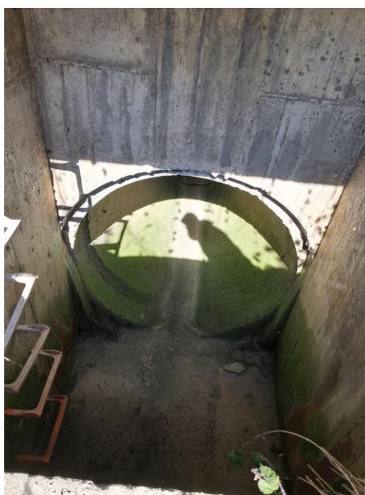
Figura 4 Interior del colector de hormigón circular de 1500 mm. Ubicación: PUNTO 4 - RÍO MENDIGORRITXU.
