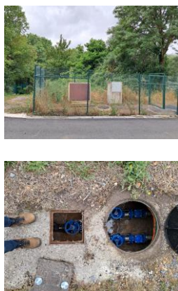
Figura 1 Arqueta de calderería (aprox. 240x140 cm). La zona de actuación presenta limitaciones de espacio para la implantación del nuevo punto de medida. Ubicación: PUNTO 8 – EDAR AMARITA.
