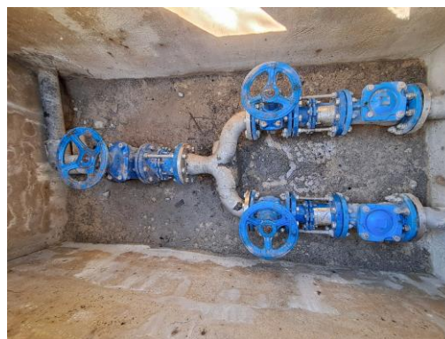
Figura 1 Arqueta de calderería (aprox. 240x140 cm). La zona de actuación presenta limitaciones de espacio para la implantación del nuevo punto de medida. Ubicación: PUNTO 8 – EDAR AMARITA.
