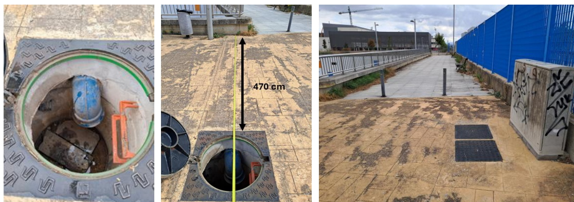
Figura 5 Vistas de la EBAP Salburua. (Izq): Pozo de rotura en carga con tubería DN200. (Centro): Zona exterior propuesta para la nueva arqueta a ejecutar por un tercero (4.7m hasta el pozo). (Der): Armario eléctrico existente para conexión. Ubicación: PUNTO 12 - EBAP SALBURUA.
