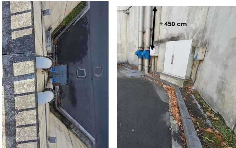
Figura 10 Vistas de la EBAP Juan de Garay. (Der): Tramos verticales de impulsión (2x DN250 Acero) a intervenir, aprox. +4.5m de altura, junto al armario eléctrico. (Izq): Vista superior de las impulsiones. Ubicación: PUNTO 17 - EBAP JUAN DE GARAY.
