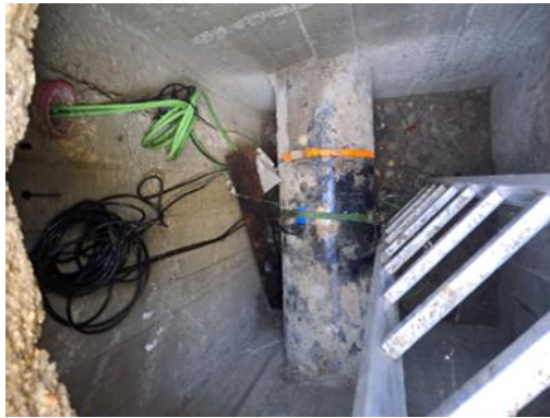
Figura 12 Vistas de la EBAP Avda. Olarizu. (Izq): Pozo de registro con la tubería de PEAD DN400 y el equipo no invasivo a sustituir. (Der): Caseta con el cuadro eléctrico y remotas (a 30m). Ubicación: PUNTO 19 - EBAP AVDA. OLARIZU.
