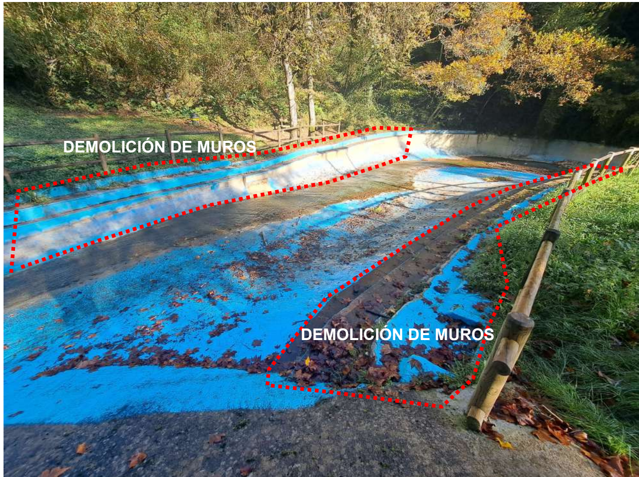
Fotografía general de los muros laterales.
