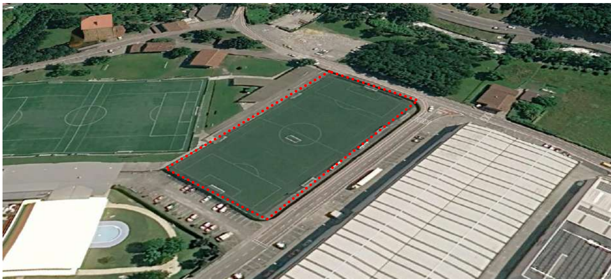
VISTA DE LAS INSTALACIONES ACTUALES DE ASTOLA.
