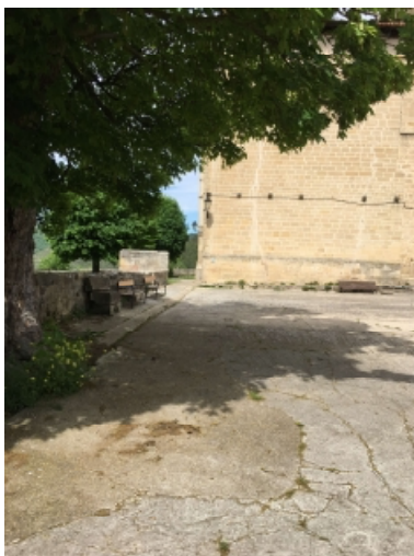
Alcorque, cuneta y pavimento.
