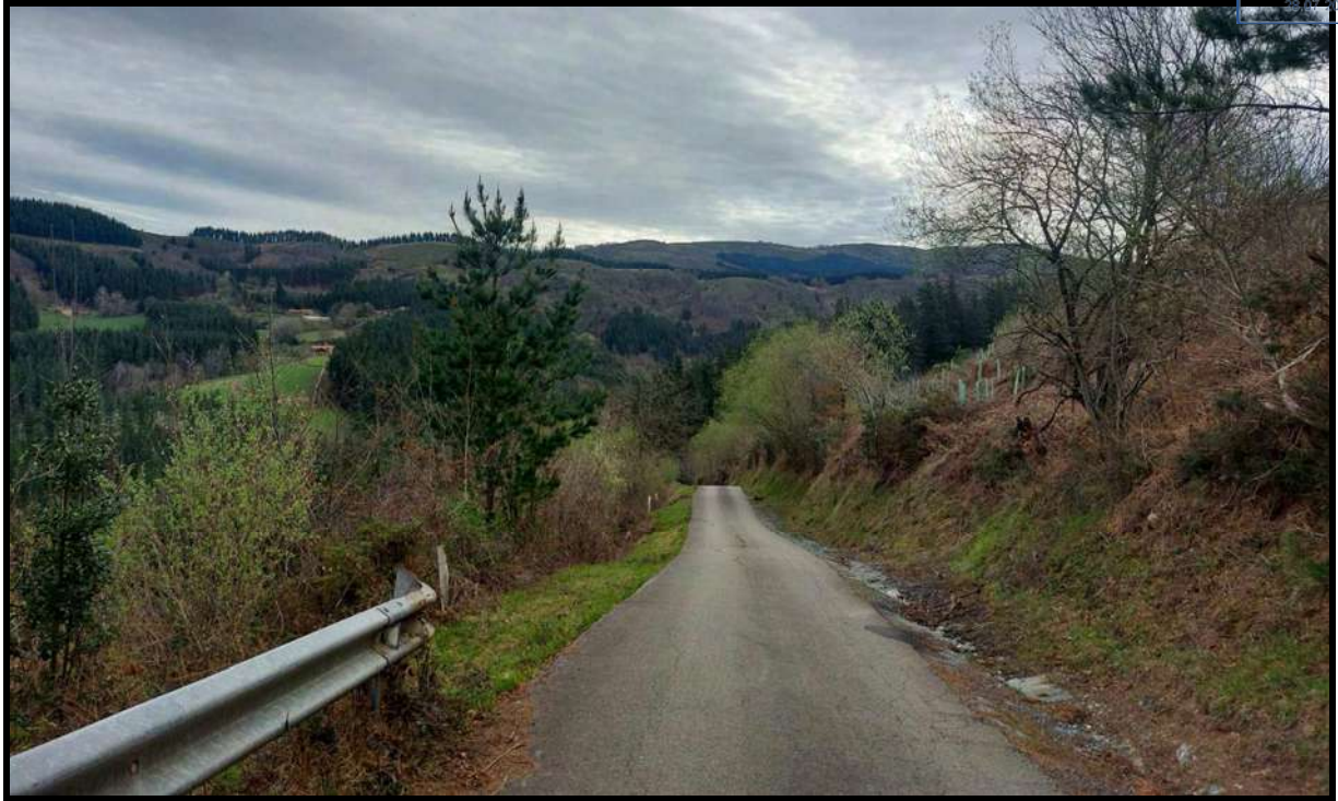
Imagen 3: Tramo de cuneta a mejorar
