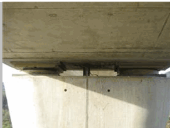
2011 13 Aparato de apoyo tipo Pot y desagüe en pila 16
