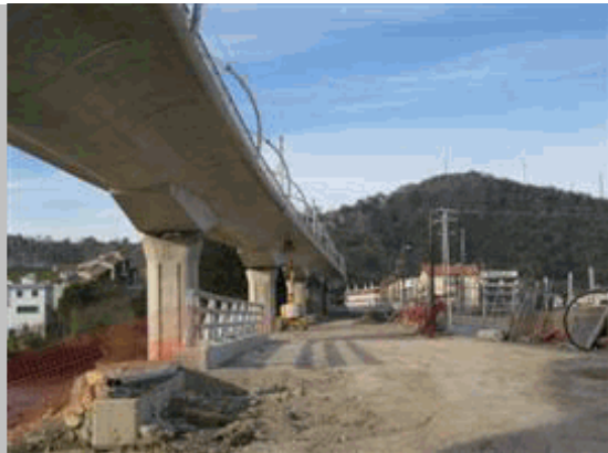
2011 25 Vista inf lado izq desde pila 11
