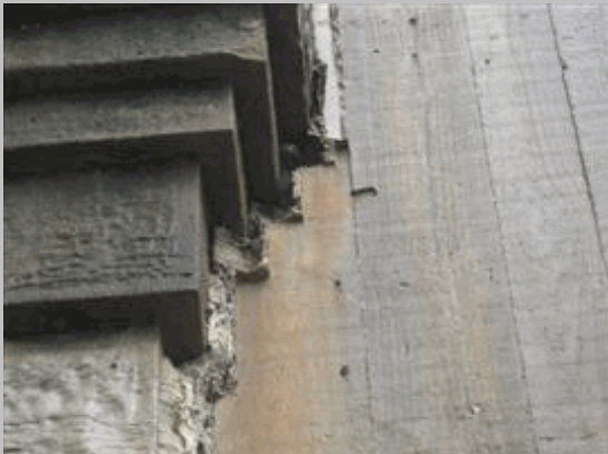
2011 141 Junta entre estribo de fábrica y ampliación de estribo de hormigón
