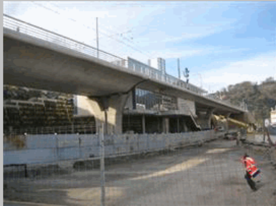
2011 30 Vista lado izq de vanos 1, 2, 3, 4 y 5
