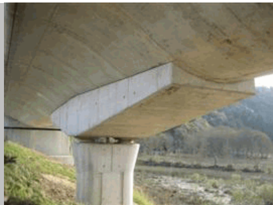
2011 14 Vista desde vano 16 de capitel en pila 16
