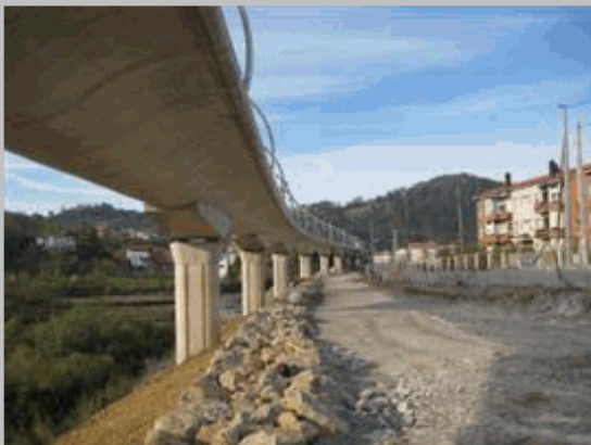
2011 21 Vista inf lado izq desde pila 14
