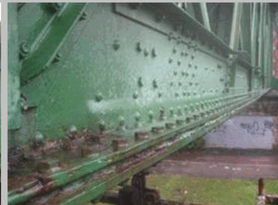
2011 69 Detalle de unión de ala inferior y ala en cordón inferior; especie de machiembrado
