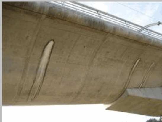
2011 22 Costra calcáreas en lado izq vano 14
