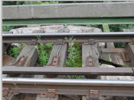
2011 105 Vegetación enraizada en pila 2
