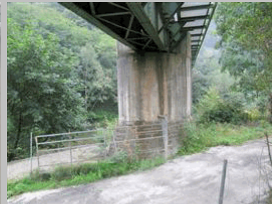
2011 77 Vista de pila 2 desde estribo 2
