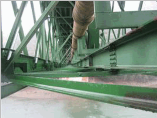
2011 106 Vista celosía vano 2 desde barquilla en pila 1
