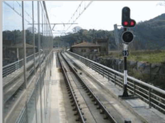
2011 53 Vista carril drch desde andén sobre vano 4 sentido pk creciente
