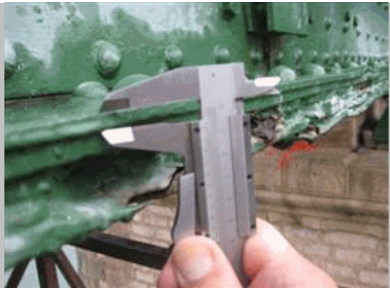
2011 25 Detalle de espesor real en cordón tras oxidación
