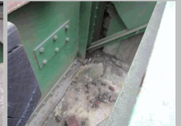
2011 109 Apoyo de viga izquierda del vano 3 sobre estribo 2
