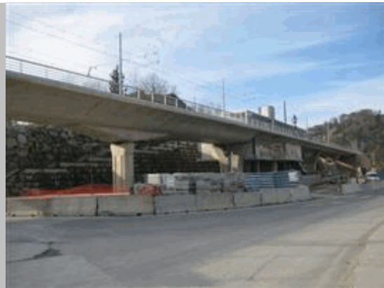
2011 28 Vista lado izq de vanos 1, 2, 3, 4 y 5
