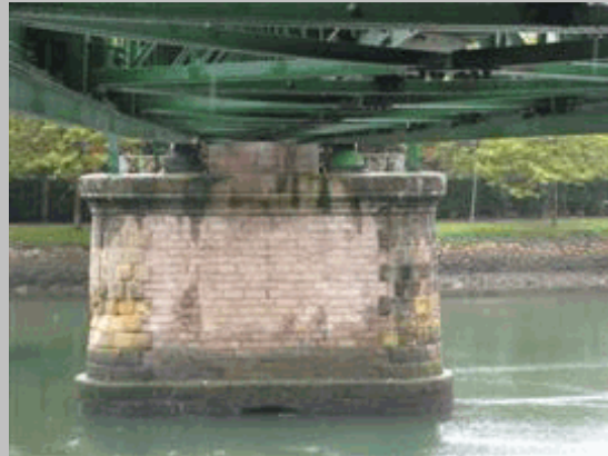
2011 123 Vista pila 1 desde vano 2
