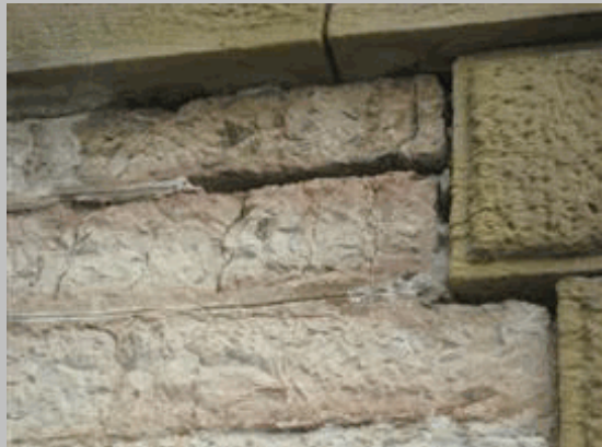
2011 140 Deslavado de junta en fábrica estribo 2
