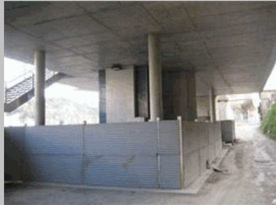
2011 34 Vista de estación de Orio en vano 4 desde pila 3 lado drch
