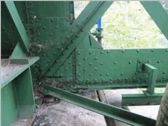
2011 186 Nudo de apoyo cercha izquierda en estribo 1
