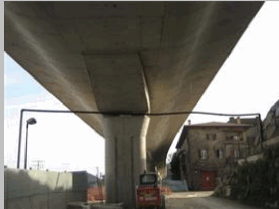
2011 33 Servicio sustentado en viaducto en pila 5 lado vano 5
