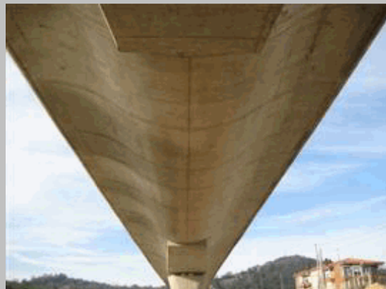
2011 18 Vista inf vano 16 desde pila 15
