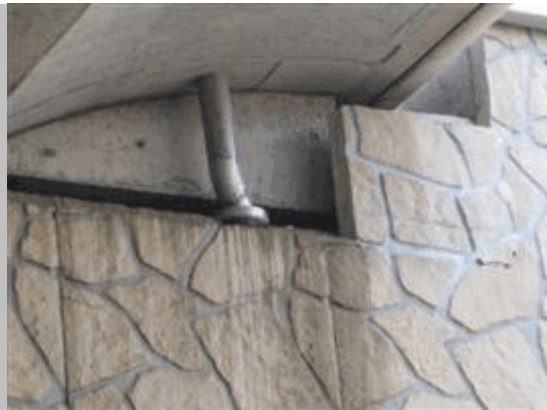
2011 42 Detalle de desagüe en E1 lado izq
