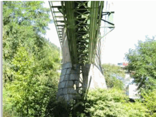
2011 40 Vista pila 1 desde estribo 1
