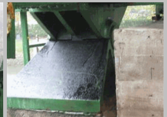
2011 99 Aparato de apoyo metálico derecho pila 1 desde vano 2
