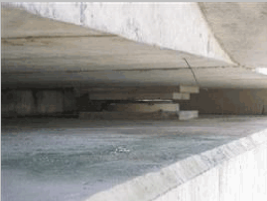
2011 07 Aparato de apoyo tipo Pot drch E2
