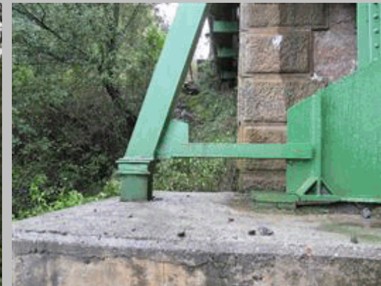
2011 153 Estabilizador izquierdo en estribo 2
