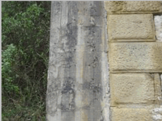
2011 143 Coqueras en hormigón en lado izquierdo estribo 2
