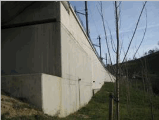
2011 04 Muro en vuelta lado drch E2
