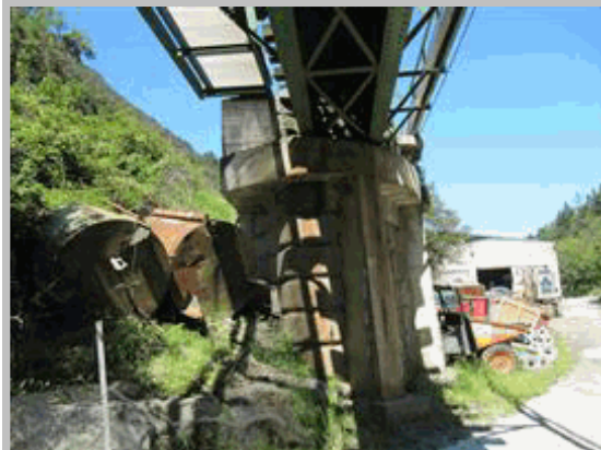
2011 90 Vista estribo 2 desde pila 2, con contrafuerte de hormigón
