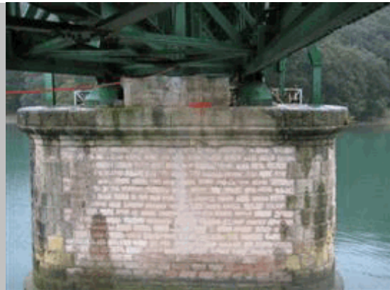
2011 44 Vista pila 1 desde vano 1
