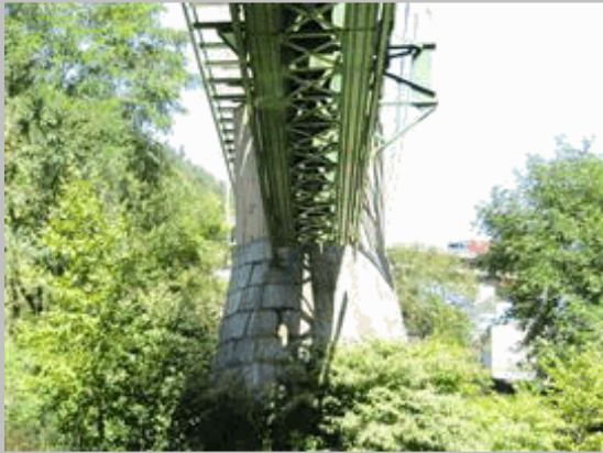
2011 22 Vista arriostramiento contraciento, en vano 1
