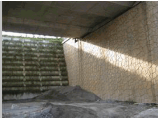
2011 44 Muro en prolongación drch E1
