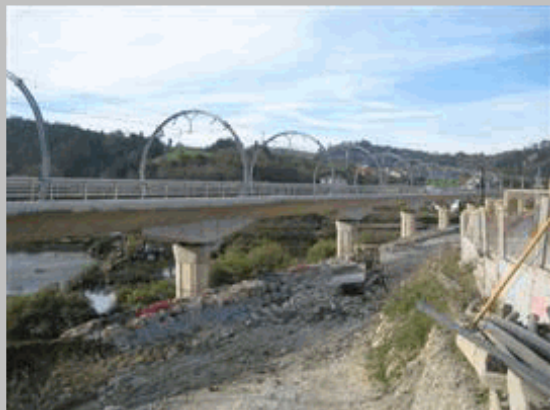
2011 20 Vista lado izq de vanos 15, 14, 13 y 12
