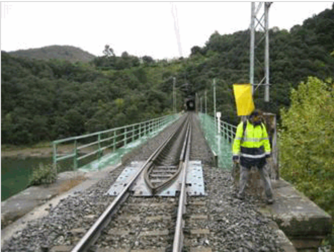
2011 167 Vista plataforma pk creciente desde estribo 1
