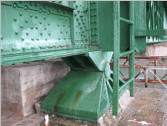
2011 01 Aparato de apoyo metálico lado derecho en pila 1
