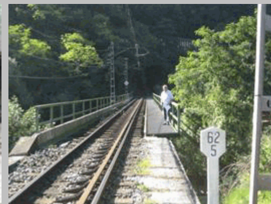
2011 98 Vista plataforma desde estribo 2 sentido pk decreciente
