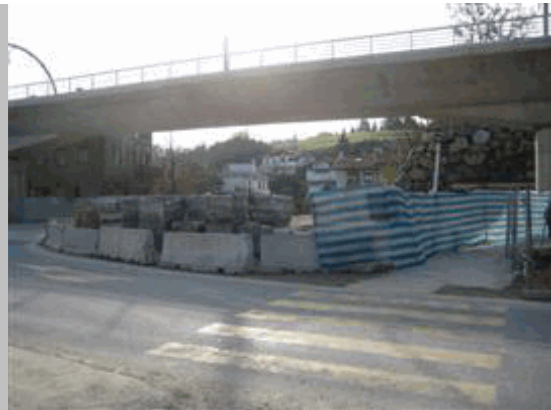
2011 29 Alzado vano 6 desde lado izq
