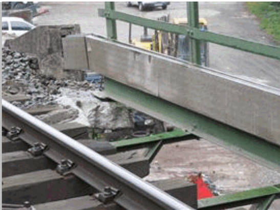
2011 131 Barandilla derecha apoyada sobre imposta de sillería en voladizo del muro en vuelta derecho del estribo2
