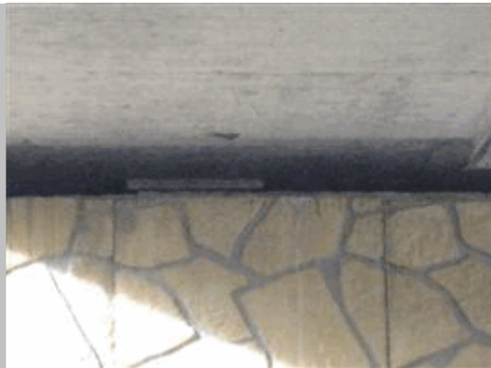
2011 41 Aparato de apoyo elastomérico en E1 lado drch
