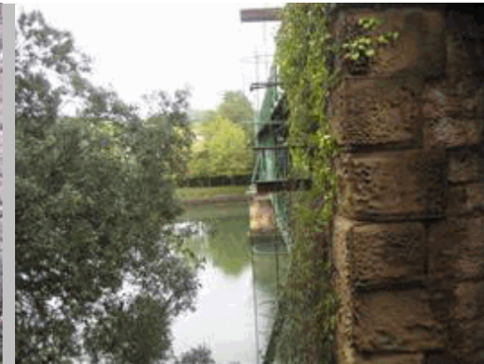
2011 148 Vista escorzo de lado derecho desde estribo 2
