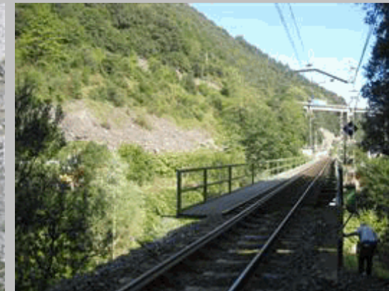
2011 123 Vista de plataforma desde estribo 1 sentido pk creciente
