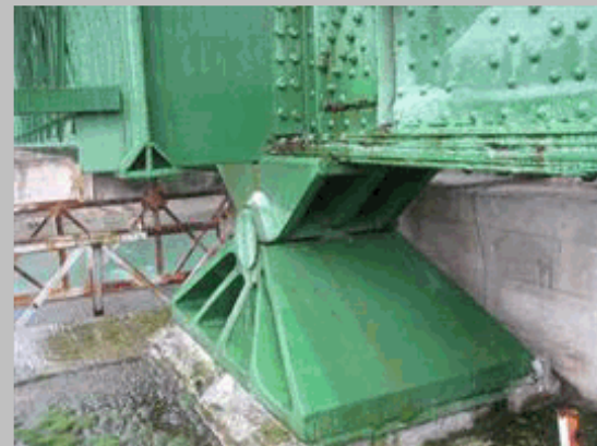
2011 16 Aparato de apoyo izquierdo pila 1
