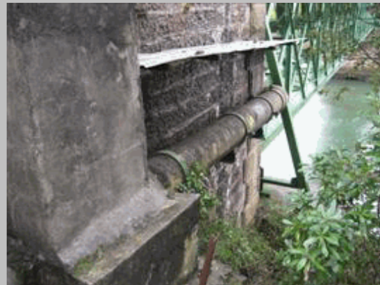
2011 151 Paso conducción por muro en vuelta izquierdo estribo 2
