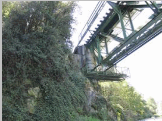
2011 15 Vista de muro en vuelta derecho estribo 1
