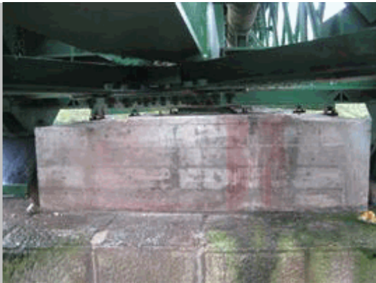
2011 101 Cargadero hormigón pila 1 desde vano 2
