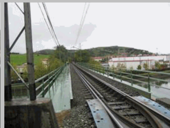
2011 157 Vista plataforma pk decreciente desde estribo 2
