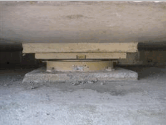
2011 06 Aparato de apoyo tipo Pot izq E2
