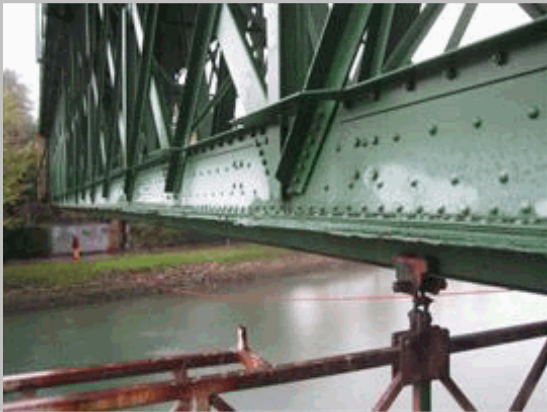
2011 02 Vista escorzo lado derecho desde barquilla vano 1 en pila 1
