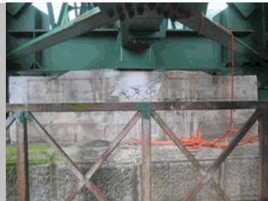
2011 11 Cargadero de hormigón en pila 1 vano 1
