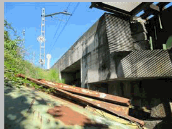
2011 92 Vista muto en vuelta del lado izquierdo del estribo 2 con viga de refuerzo de hormigón sobre contrafuerte
