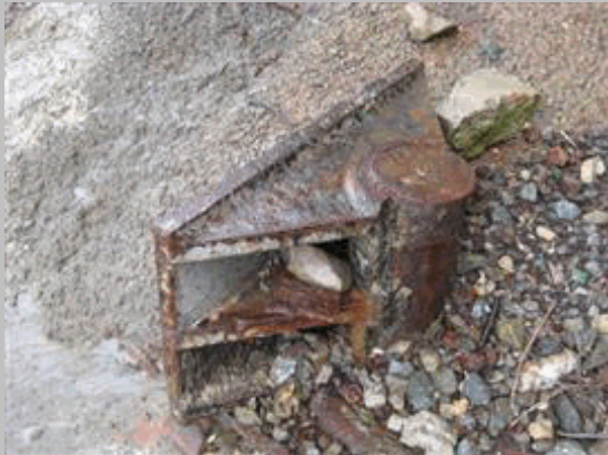
2011 137 Aparatos de apoyo metálicos contiguos en orilla de río
