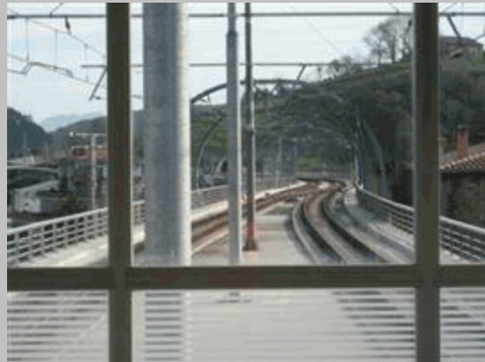
2011 54 Vista desde interior de estación sobre vano 4 sentido pk creciente
