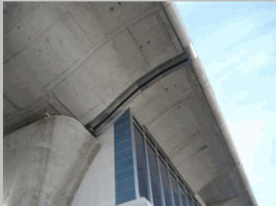
2011 50 Detalle de junta de dilatación sobre pila 4 lado izq
