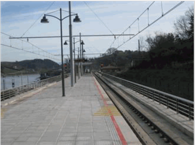
2011 52 Vista desde andén sobre E1 sentido pk creciente
