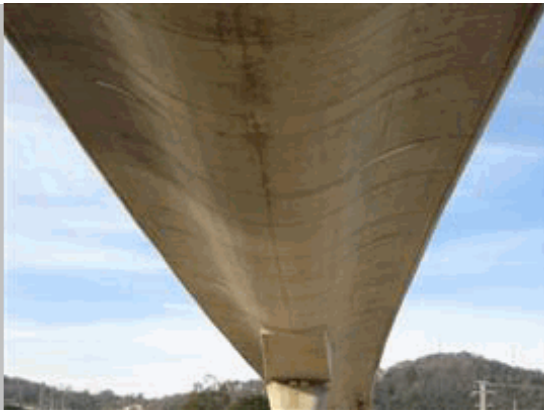
2011 26 Vista inf vano 11 desde pila 11
