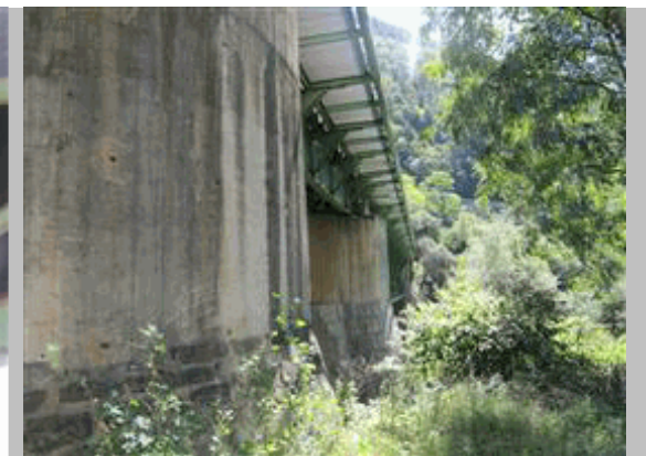
2011 89 Vista en escorzo desde estribo 2
