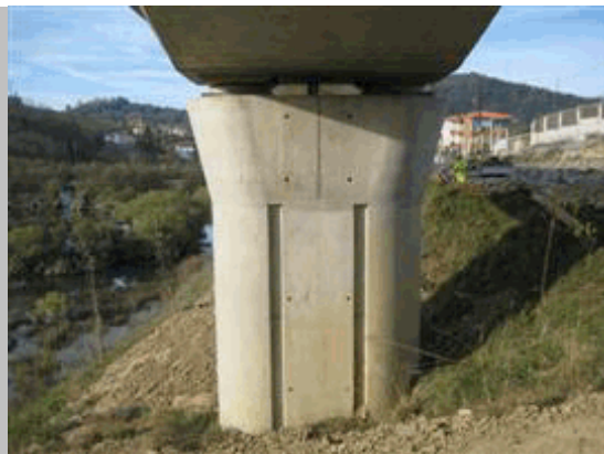
2011 12 Alzado pila 16 desde vano 17
