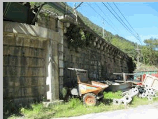
2011 91 Vista muro en vuelta del lado derecho del estribo 2
