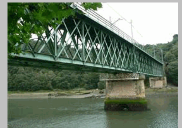
2011 204 Escorzo de lado derecho desde estribo 1
