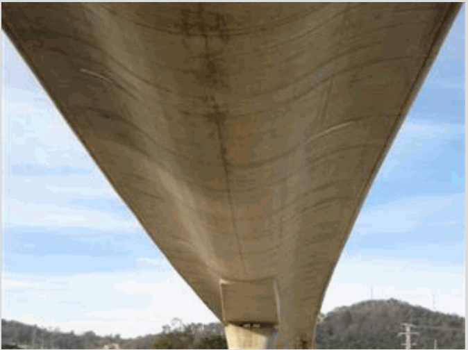
2011 26 Vista inferior vano 11 desde pila 11
