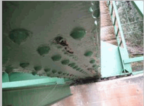
2011 129 Apoyo cercha derecha en estribo 2
