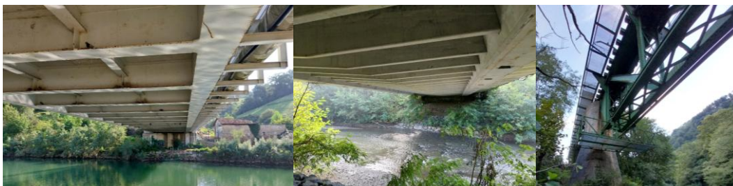
Viaductos sin acceso bajo tablero. Viaducto con cesta para inspección sin acceso directo a ella
