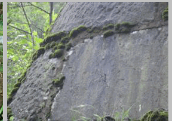
2011 54 Pátina biológica en lado derecho de la pila 1
