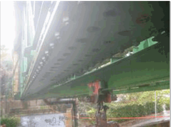
2011 72 Detalle de perforaciones en pletina para correcta unión de pletina de refuerzo
