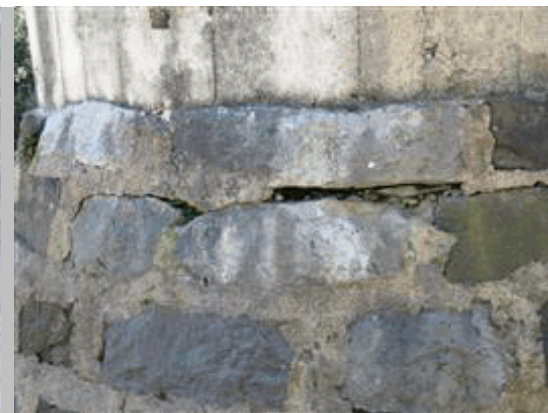
2011 87 Deslavado de junta en fábrica de pila 2, en el lado del vano3
