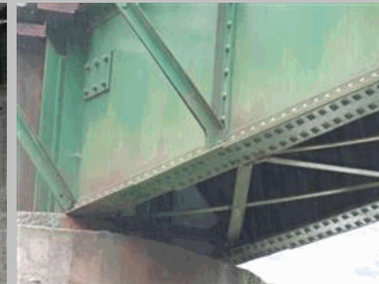
2011 63 Apoyo vano 2 sobre pila 1
