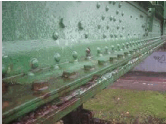
2011 70 Detalle de unión de ala inferior y ala en cordón inferior; especie de machiembreado
