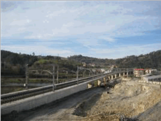
2011 60 Vista superior viaducto desde lado izq
