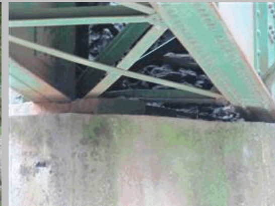
2011 78 Apoyo de viga derecha de vano 3 sobre pila 2
