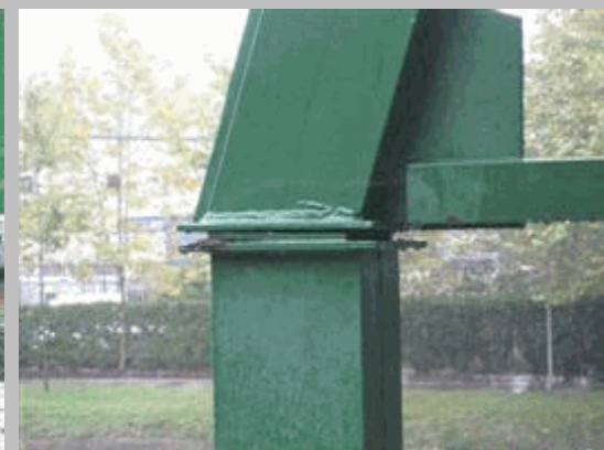
2011 97 Estabilizador derecho pila 1 con chapa de continuidad
