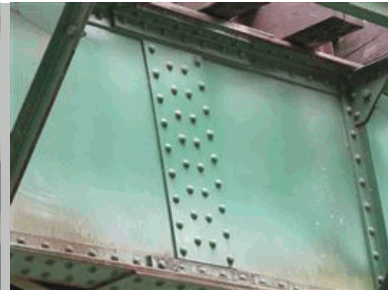
2011 72 Uniones roblonadas en viga izquierda del vano 2 en centro de luz, en buen estado
