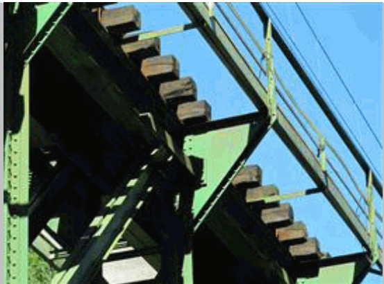
2011 29 Detalle de unión mediante voladizo de barandilla lado derecho con celosía
