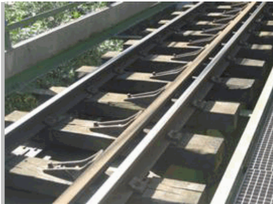
2011 100 Travesías de madera sobre plataforma con aparatos de vía
