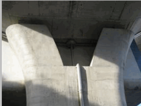
2011 32 Detalle de desagüe en pila 4
