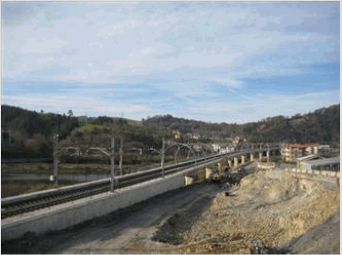
2011 60 Vista superior viaducto desde lado izquierdo
