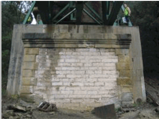
2011 134 Alzado estribo 2 con cargadero de hormigón
