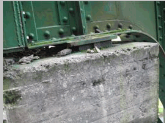
2011 121 Aparato de apoyo elastomérico de celosía derecha del vano 1 en estribo 1
