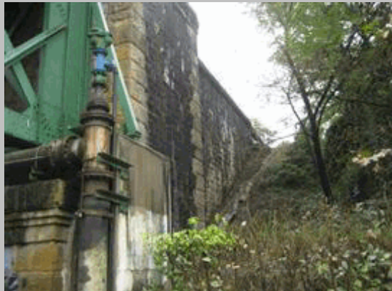
2011 185 Vista muro en vuelta lado izquierda estribo 1
