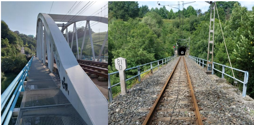
Viaducto con paseo de mantenimiento
