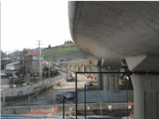
2011 55 Vista inf lado izq desde vano 4
