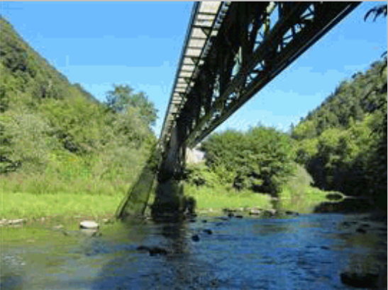
2011 06 Vista inferior desde estribo 1
