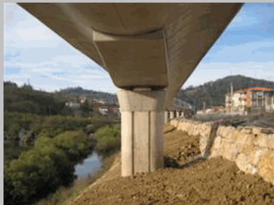
2011 17 Alzado pila 15 desde vano 16
