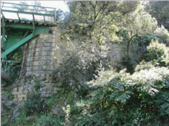
2011 08 Vista de muro en vuelta izquierdo
