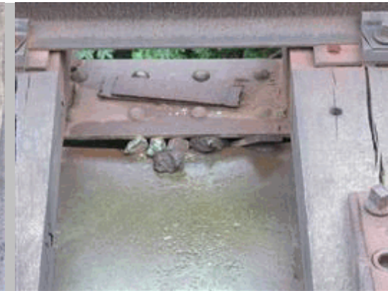
2011 103 Balasto y placas de nivelación entre chapa superior y ala superior de viga derecha en vano3
