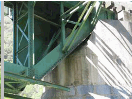
2011 42 Apoyo de celosía en pila 1 sobre cargadero de hormigón
