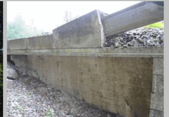
2011 124 Vista de muro en vuelta derecho de hormigón del estribo 1
