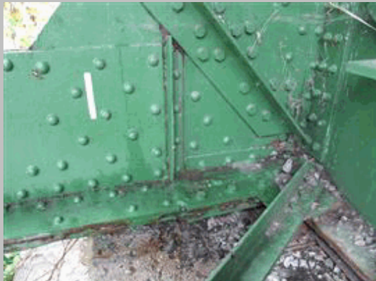
2011 188 Nudo de apoyo de cercha derecha en estribo 1
