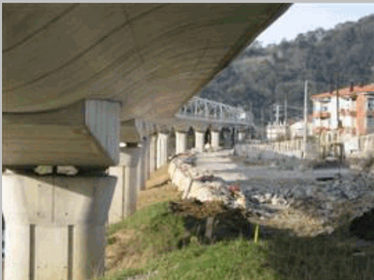
2011 08 Vista inf lado izq desde vano 17
