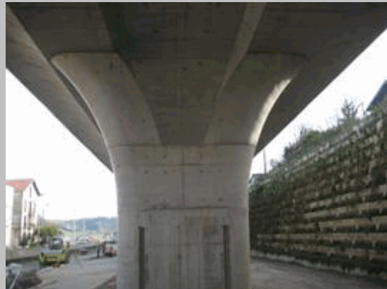
2011 38 Alzado pila 1 desde vano 1
