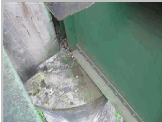
2011 110 Apoyo de viga izquierda del vano 3 sobre estribo 2
