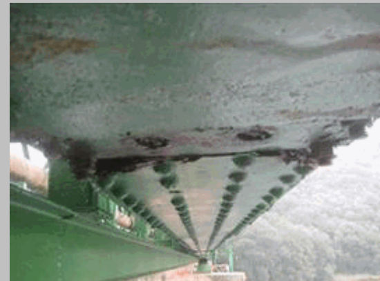
2011 63 Vista cordón inferior derecho desde abajo en zona de maximo momento positivo vano 1
