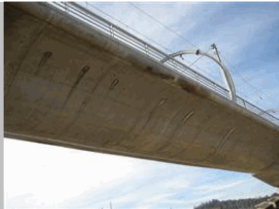
2011 27 Costras calcáreas en lado izq vano 10
