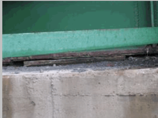
2011 128 Taco de madera bajo diafragma de apoyo en 4estribo 2
