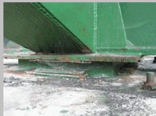
2011 96 Apoyo neopreno cercha central en vano 2
