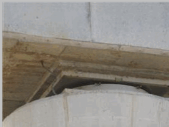
2011 23 Detalle de puesta a tierra en pila 13
