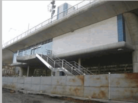
2011 49 Vista vano 4 desde lado izq
