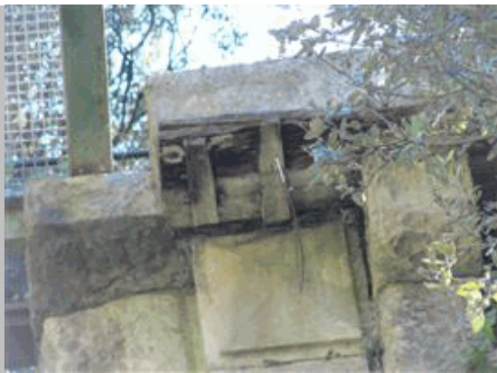
2011 14 Encofrado de madera en imposta de muro en vuelta izquierdo de estribo 1
