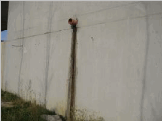
2011 05 Detalle de desagüe en muro en vuelta lado drch E2
