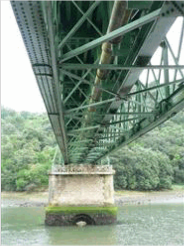
2011 203 Vista de pila 1 desde estribo 1
