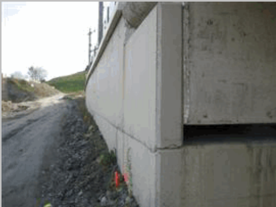
2011 02 Muro en vuelta lado izq E2
