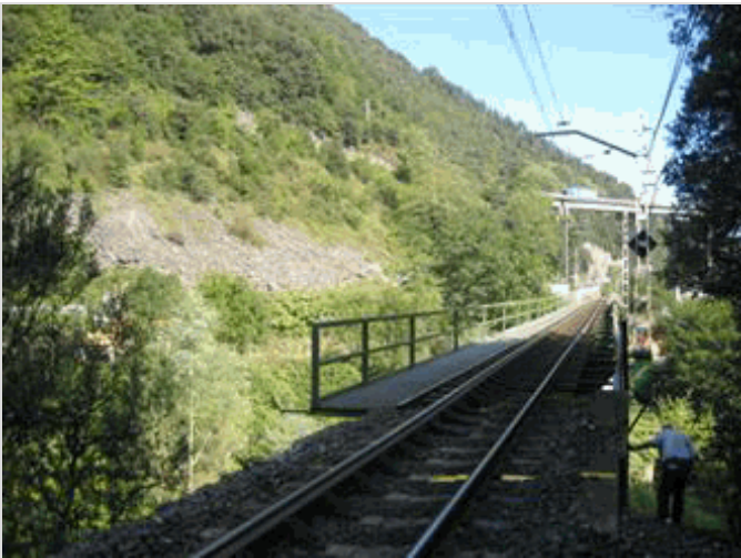
2011-123 Vista de plataforma desde E1 sentido pk creciente
