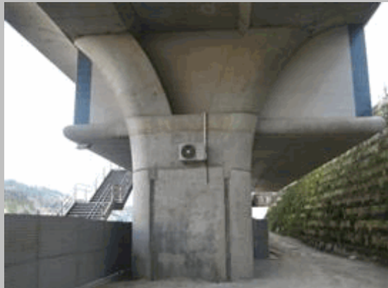
2011 35 Alzado pila 3 desde vano 3
