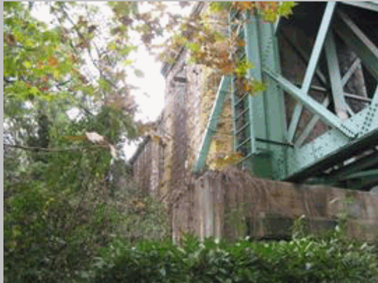
2011 183 Vista muro en vuelta lado derecho estribo 1
