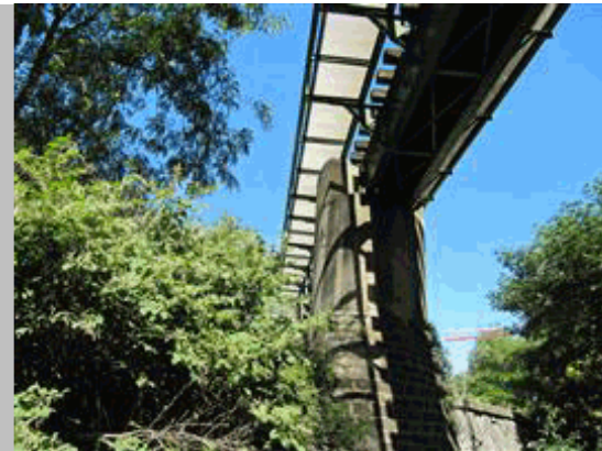
2011 56 Vista pila 2 desde pila 1
