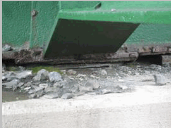
2011 127 Apoyo cercha central en estribo 2
