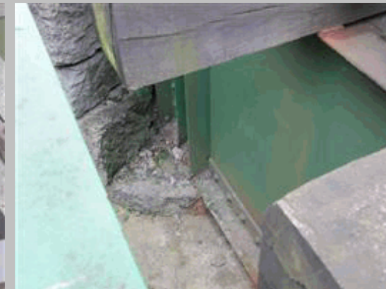
2011 108 Apoyo de viga izquierda del vano 2 sobre pila 2
