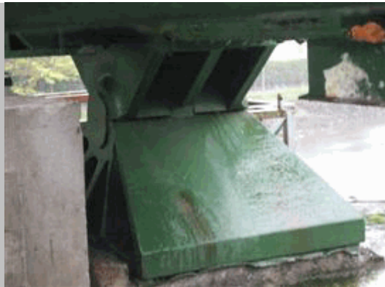
2011 100 Aparato de apoyo metálico izquierdo pila 1 desde vano 2
