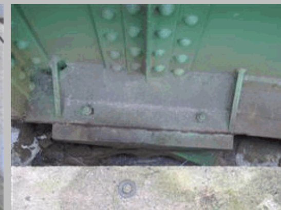
2011 113 Aparato de apoyo metálico de celosía izquiera sobre pila 1
