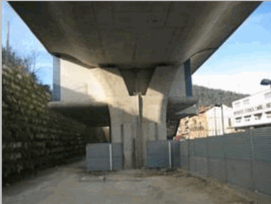
2011 31 Alzado pila 4 desde vano 5
