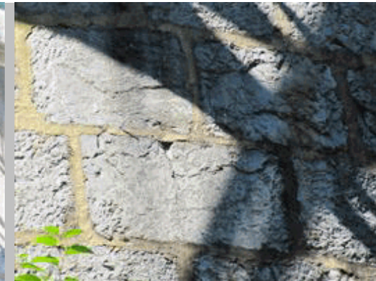
2011 43 Detalle de rejunteado de sillería en pila 1
