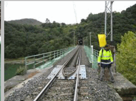
2011 167 Vista plataforma pk creciente desde estribo 1
