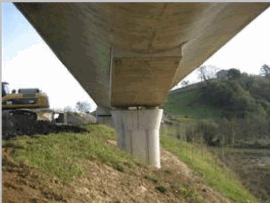
2011 16 Alzado pila 16 desde vano 16
