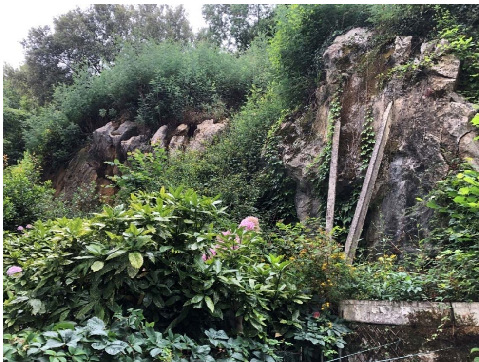
Zona con refuerzos
