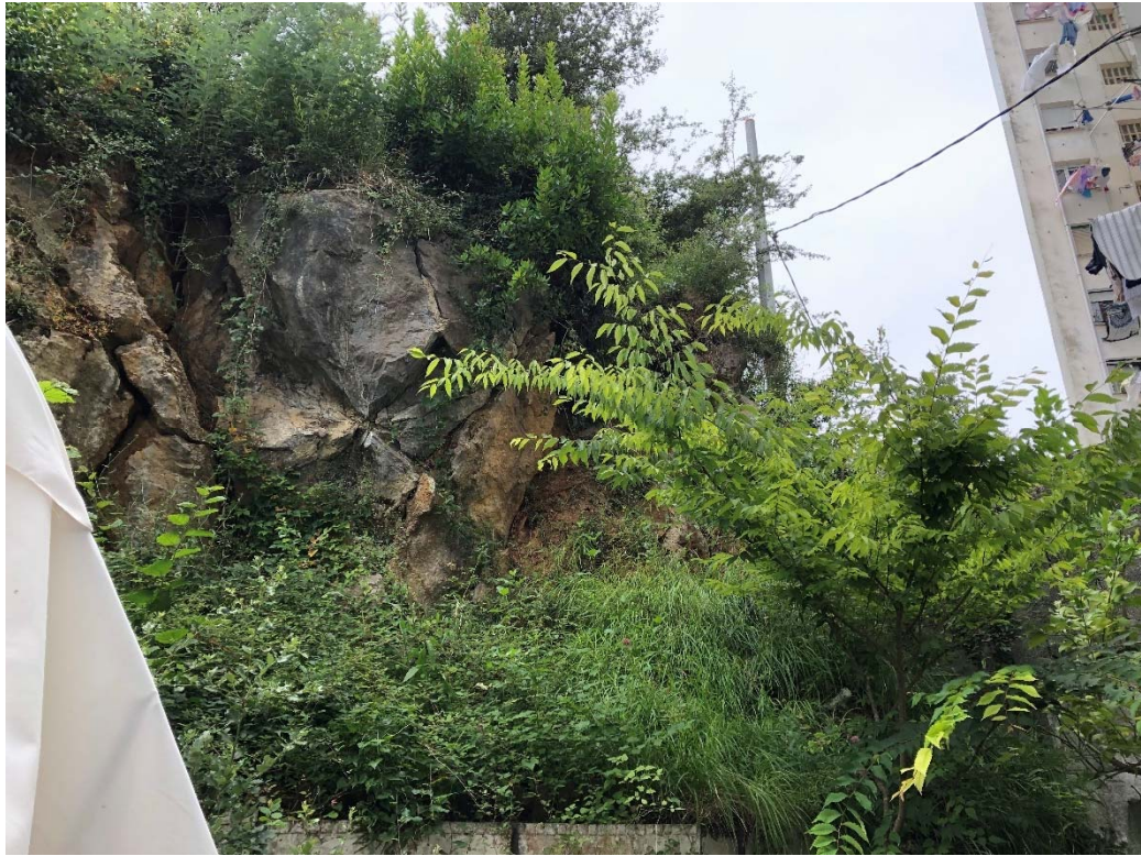
Detalle de cuñas potencialmente inestables
