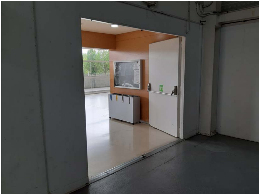
Foto.07 Vista del Acceso a Pabellón y tapajuntas actual de Chapa Galvanizada.
