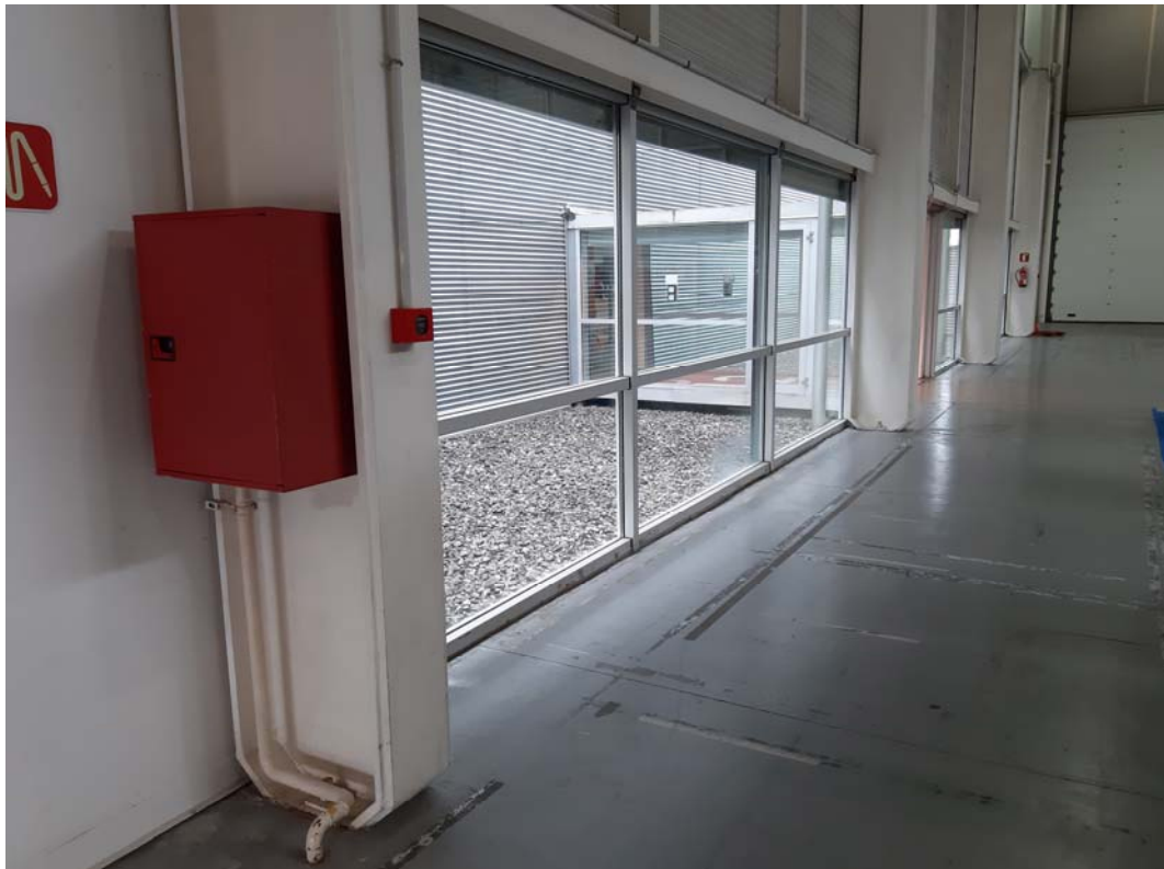
Foto.08 Vista del encuentro del Pavimento con Muro Perimetral y con Carpintería Metálica.
