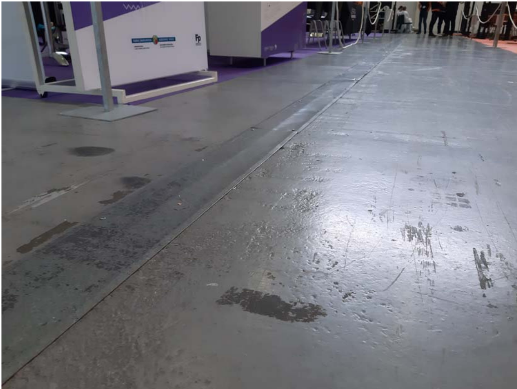
Foto.09 Vista de la Junta de dilatación con tapajuntas en chapa galvanizada en Pabellones 1 y 2.
