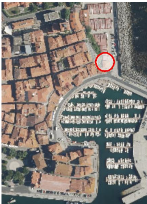
Figura 1. Localización ubicación edificio a rehabilitar
