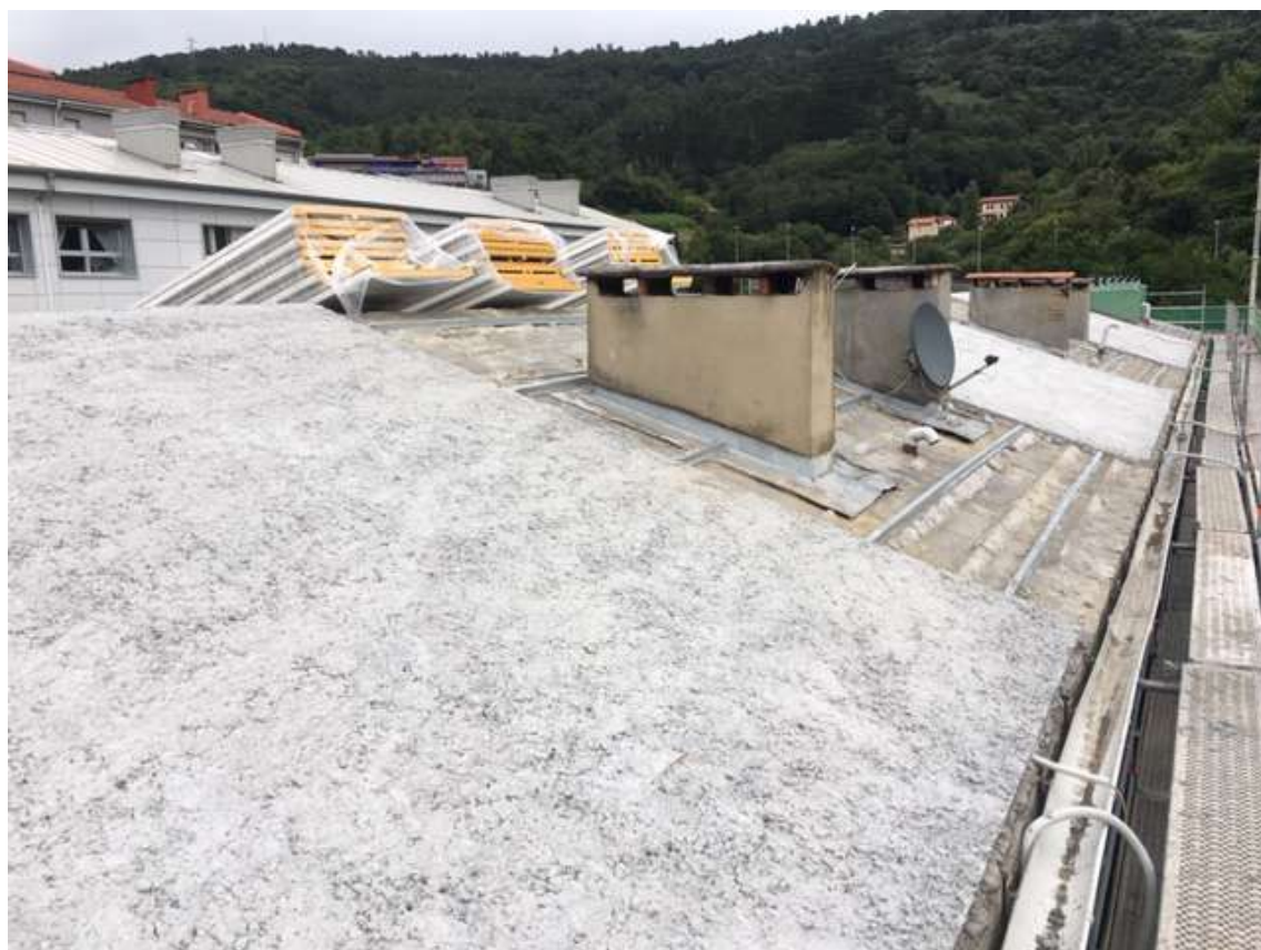
Figura 1: refuerzo de hormigón realizado en las zonas en las que se instalarán los módulos fotovoltaicos en la cubierta del edificio Txotena 18 – 20 – 22 – 24.
