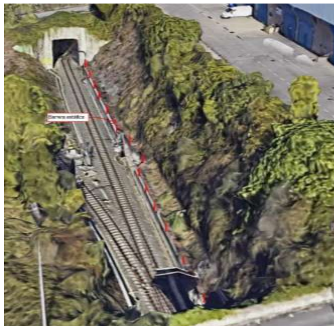
Tramo 2. Entre pasos superiores
