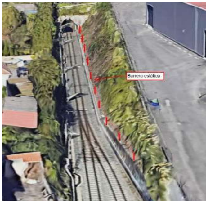
Tramo 1. Entre la estación de Larrondo y el primer paso superior
