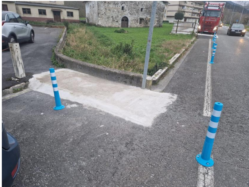
Zona peatonal provisional, habilitada para alcanzar la acera ejecutada en la FASE 1º.
