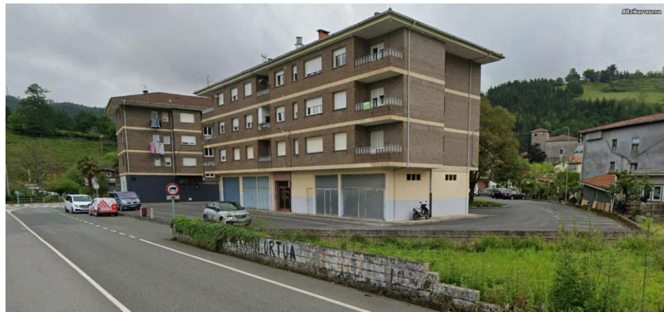
Parada de camiones, aldapara y vial residencial
