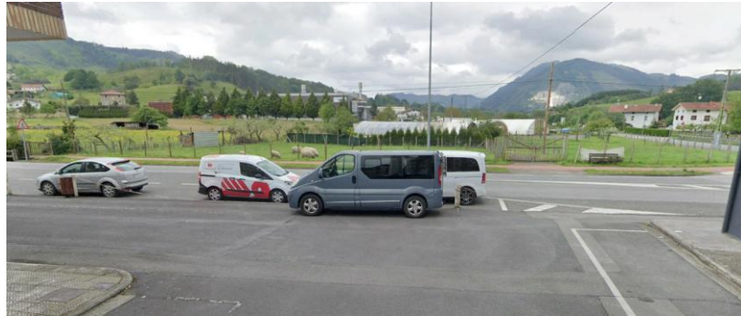
Aceras inconexas y con resaltos.
