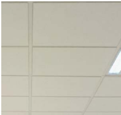
Falso techo desmontable placa escayola
