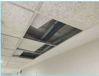
Falso techo desmontable placa tipo viruta
