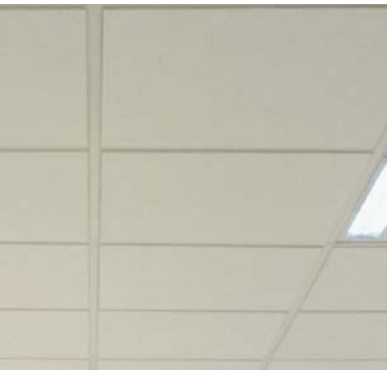
Falso techo desmontable placa escayola
