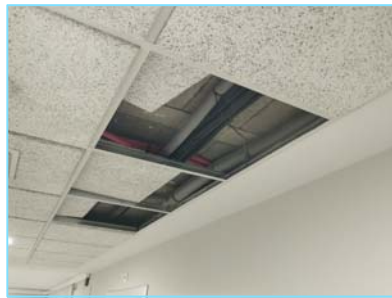
Falso techo desmontable placa tipo viruta
