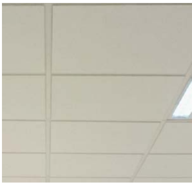
Falso techo desmontable placa escayola
