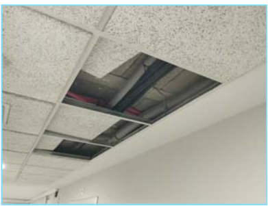
Falso techo desmontable placa tipo viruta
