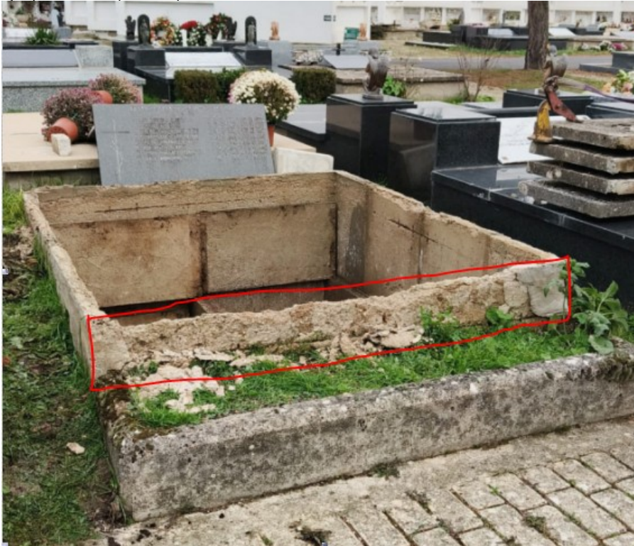
Ejemplo de muro a picar completamente.
