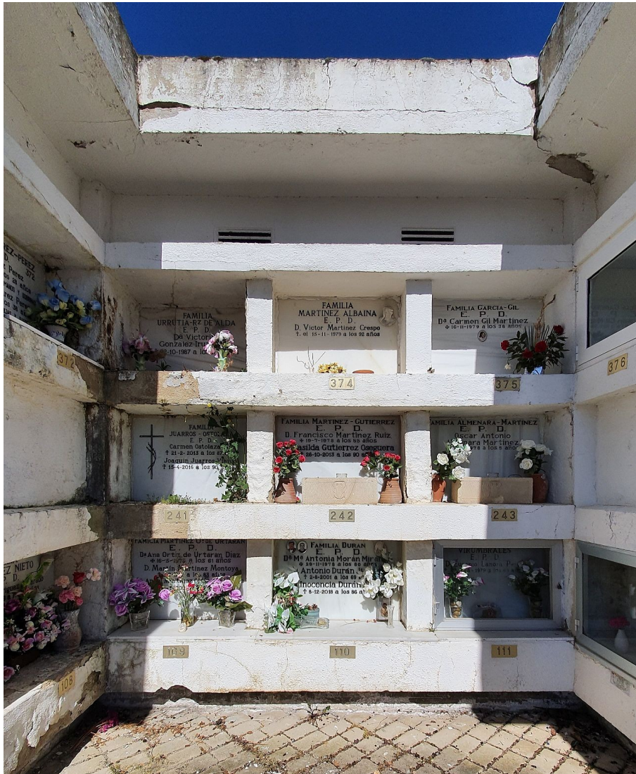
Ejemplo de reparación de fachada de nichos
