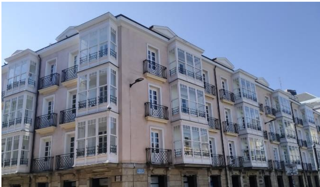
Oficinas Técnicas Nuevas. Fachadas norte y este
