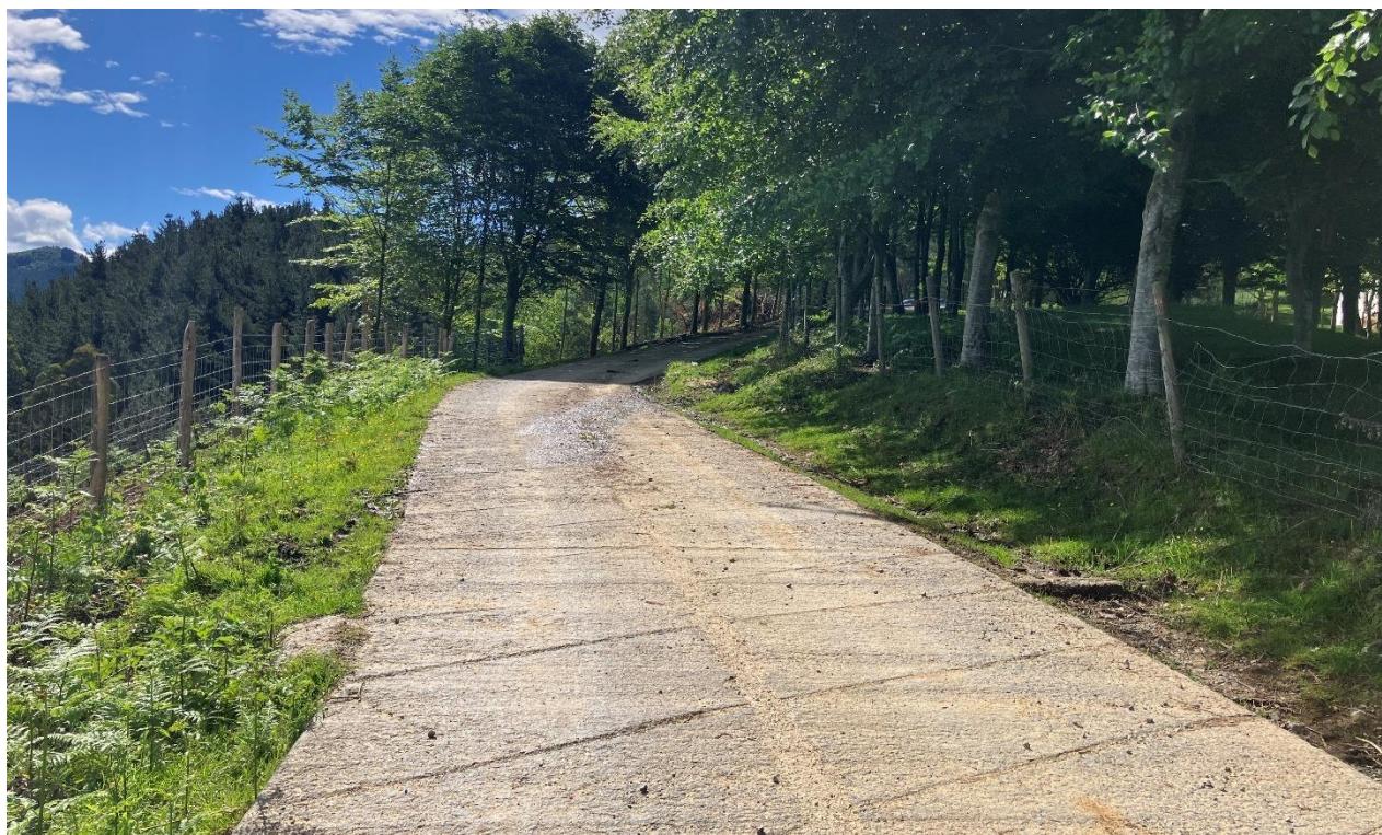
Tramo de pista hormigonada (P.K. +1,500 – P.K. +1,600)
