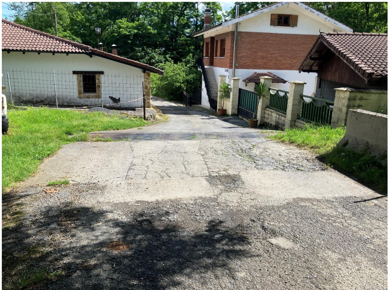
Barrio Aldana 3-4 y canaleta transversal (P.K. +0,700)
