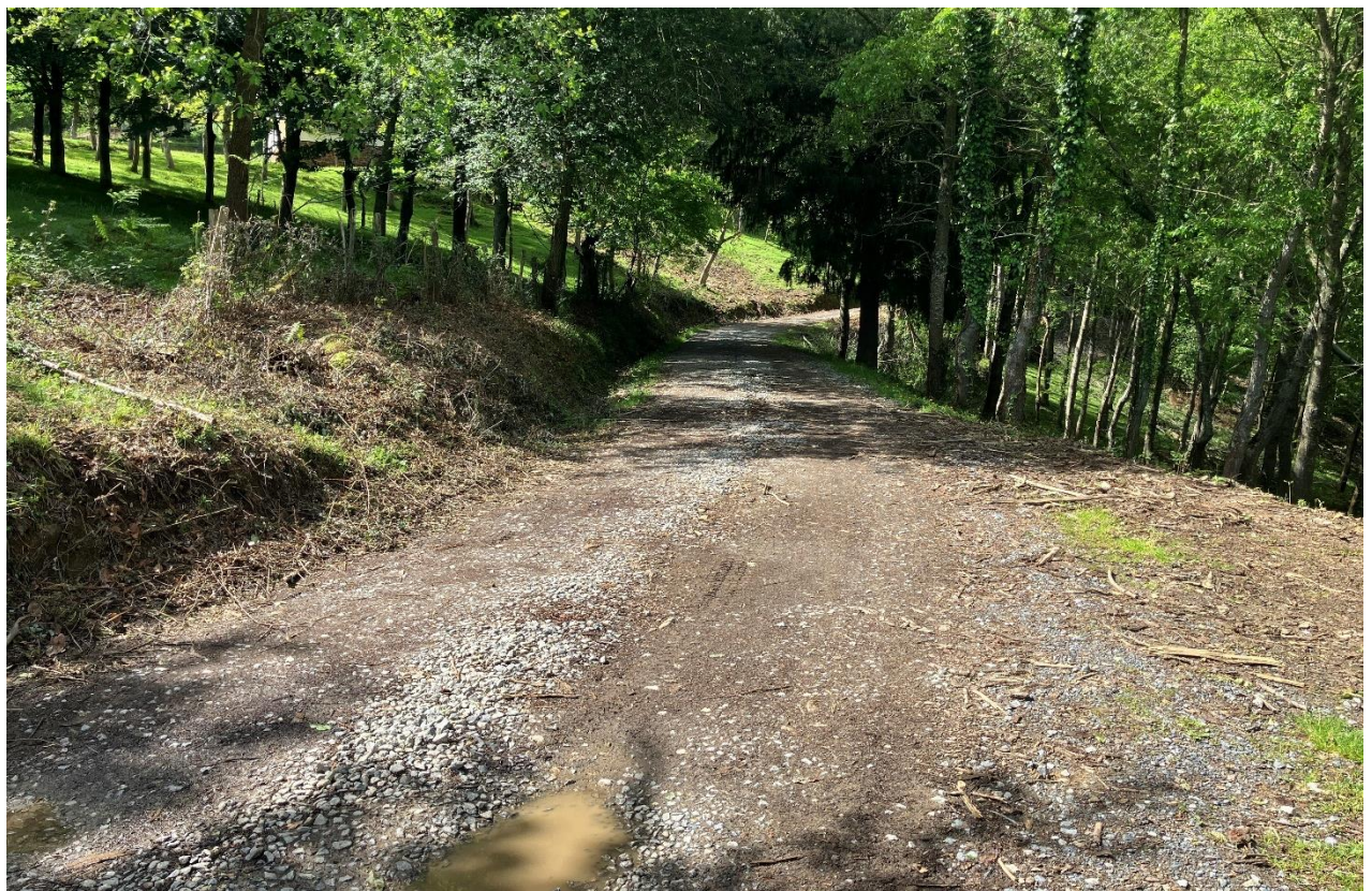
Estado actual de la pista forestal
