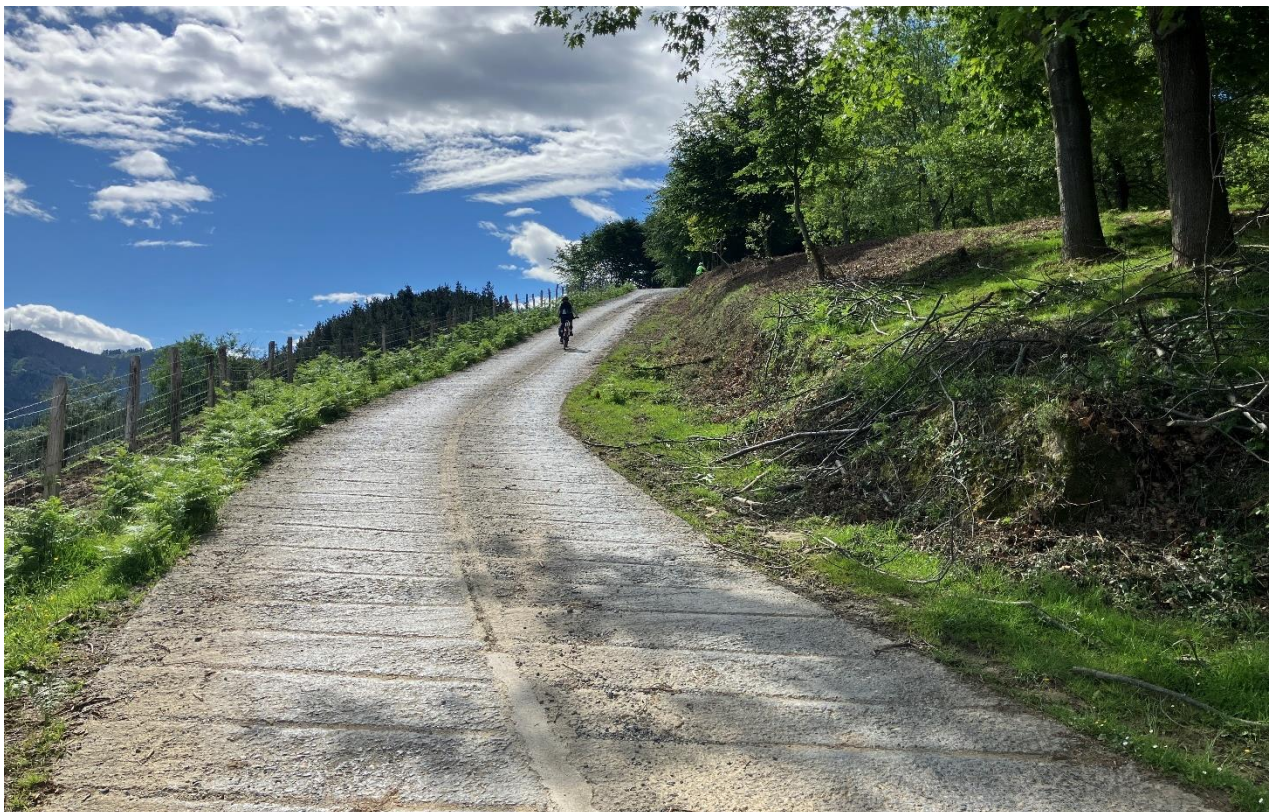
Hormigón rayado (P.K. +1,330 – P.K. +1,500)
