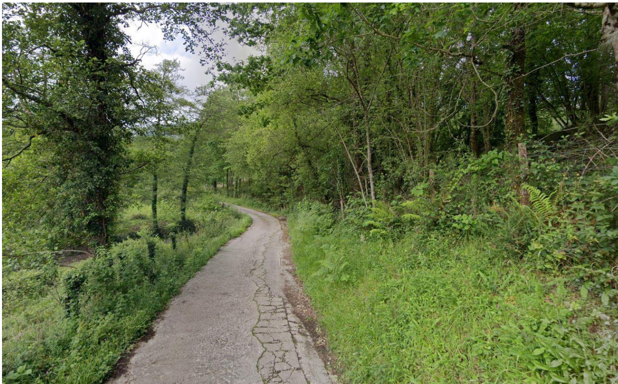
Foto 5 (p.k. 120,00 sentido descendente)
