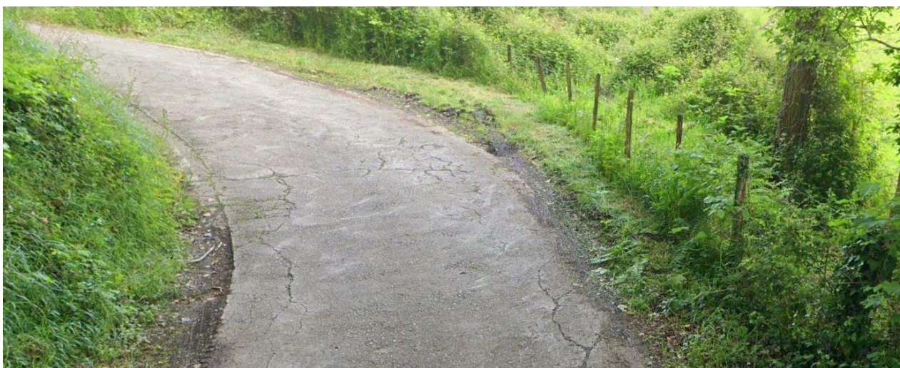
Foto 8 (p.k. 270,00 sentido ascendente)
