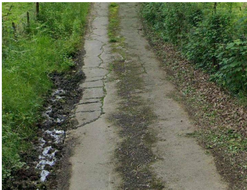
Foto10 (p.k. 350,00 sentido descendente)
