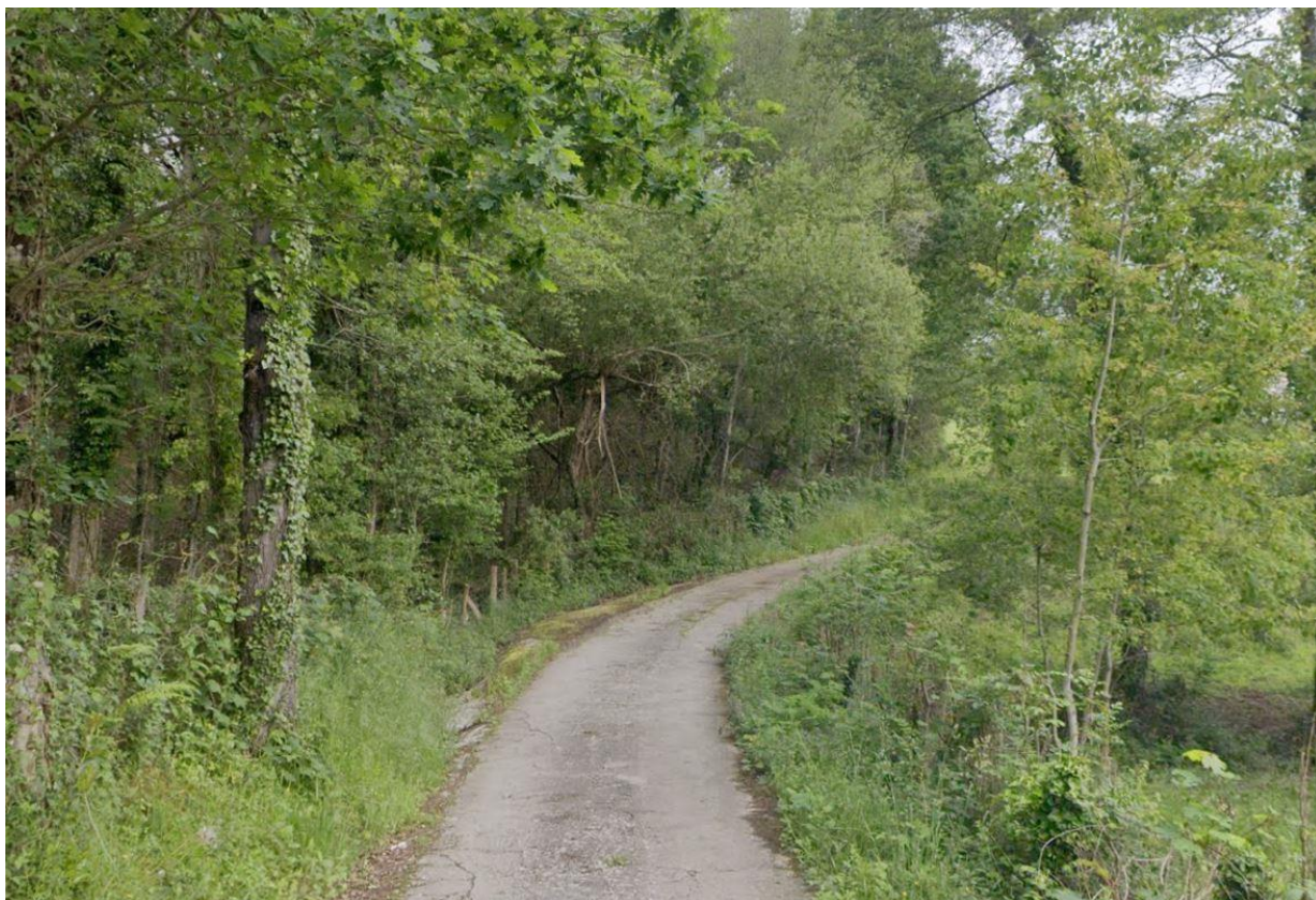
Foto 3 (p.k. 120,00 sentido ascendente)
