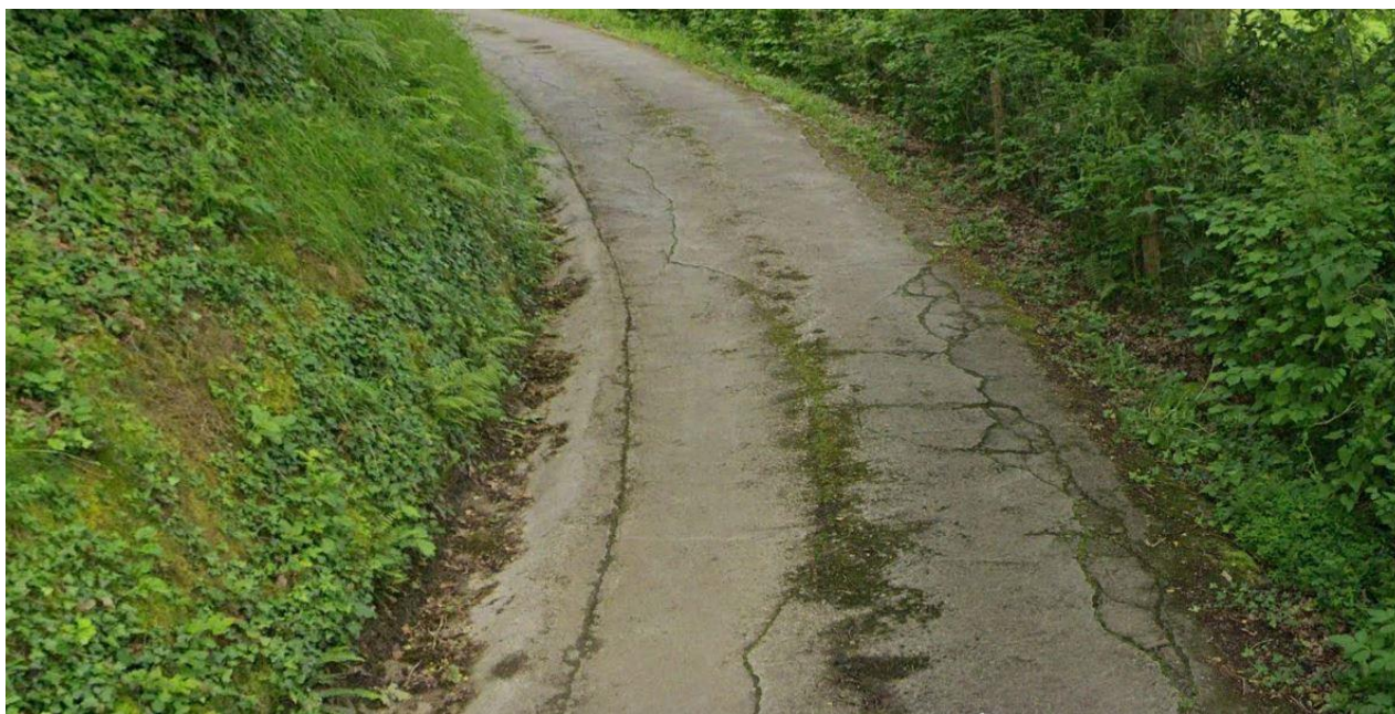
Foto 6 (p.k. 150,00 sentido ascendente)
