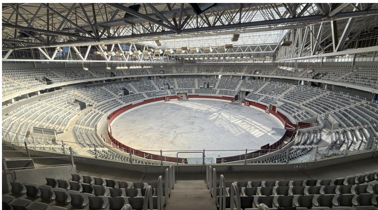
Panorámica actual del interior del Iradier Arena
