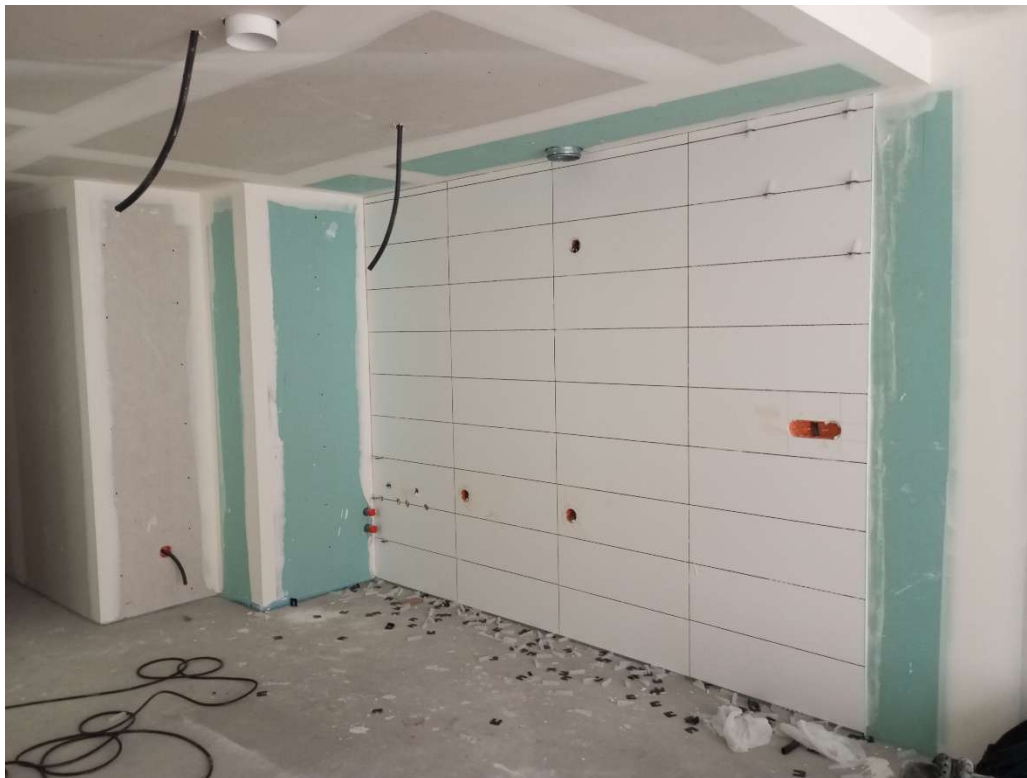
Instalaciones y acometidas en obra. Cocina tipo (P1a P3). Mano izda.
