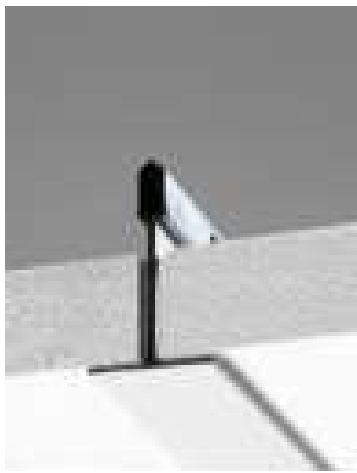
Unión falso techo
