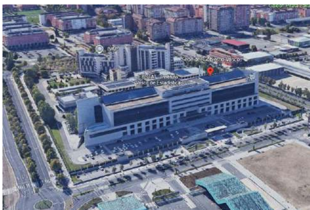
Vista aérea del edificio
