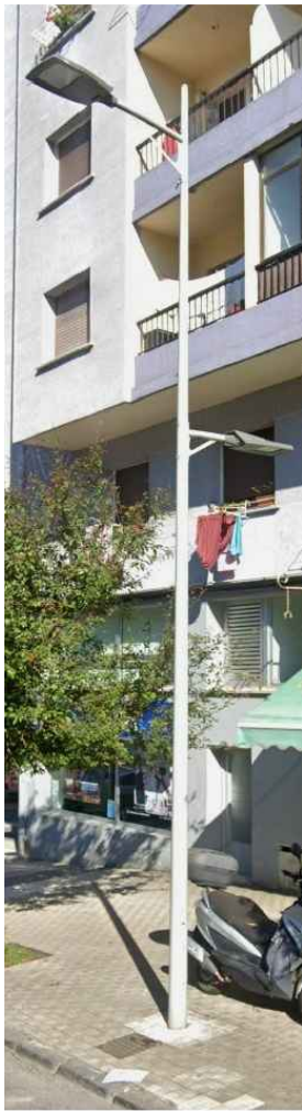
COLUMNA TRONCOCÓNICA CON LUMINARIA A 9m Y BRAZO A 4m.
