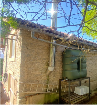
Chimenea en la fachada noreste proveniente de una chimenea interior sin uso. Se va a retirar.
