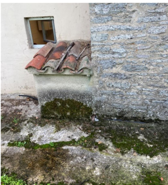
Pequeño volumen anejo a la fachada norte sin uso. Se derribará.
