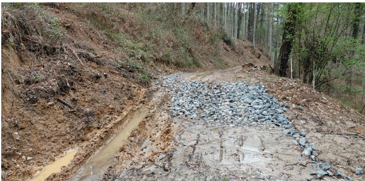
Ilustración 4: Fotografía de la zona de obra, situación actual.
