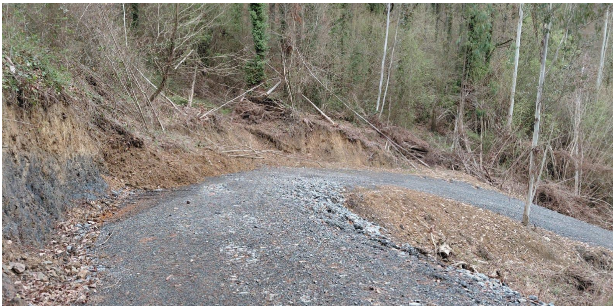
Ilustración 5: Fotografía de la zona de obra, situación actual.
