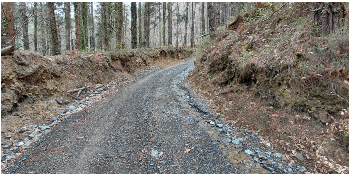
Ilustración 6: Fotografía de la zona de obra, situación actual.
