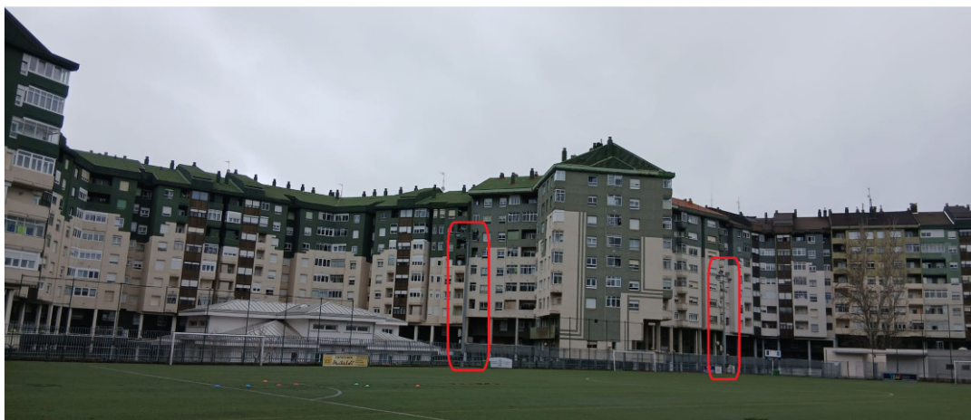
Figura 4: Fotografía del estado actual del campo de fútbol CF Aranzizarra , con detalle de 2 de los báculos con los focos de iluminación. En total dispone de 6 báculos.
