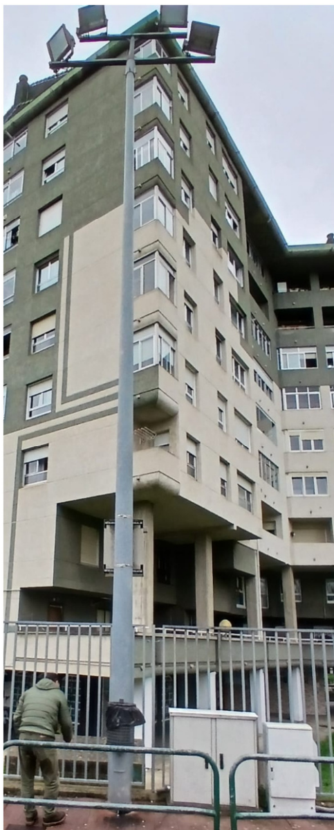
Figura 2: Detalle de un báculo desde la parte frontal, con 4 luminarias, a 2 alturas (6 marzo de 2026)
