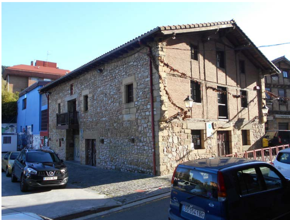
Imagen 2- Fachada principal del caserío
