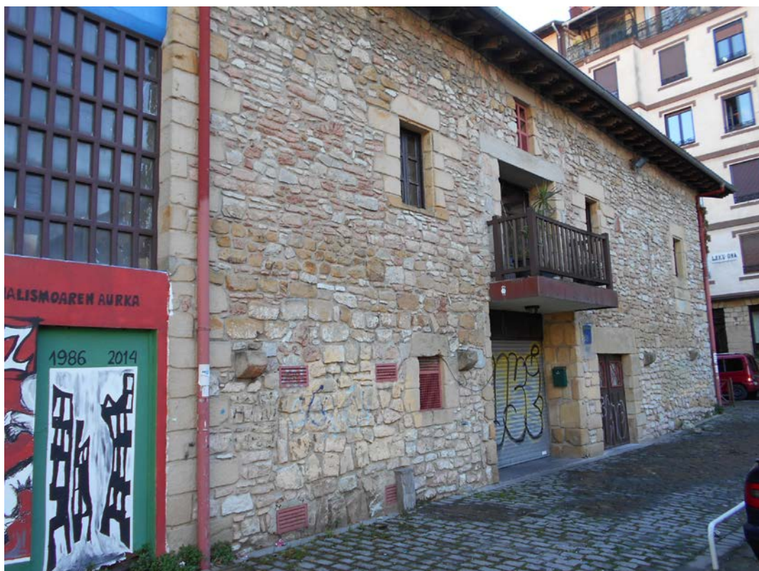
Imagen 4- Fachada oeste, zona caserío
