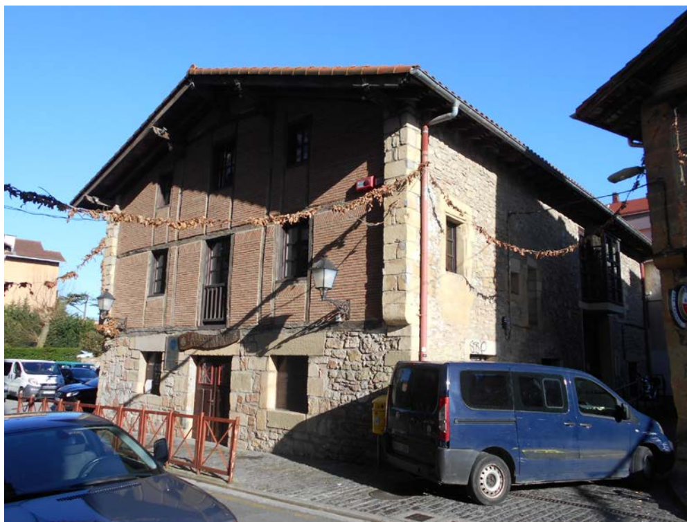
Imagen 3- Fachada principal del caserío
