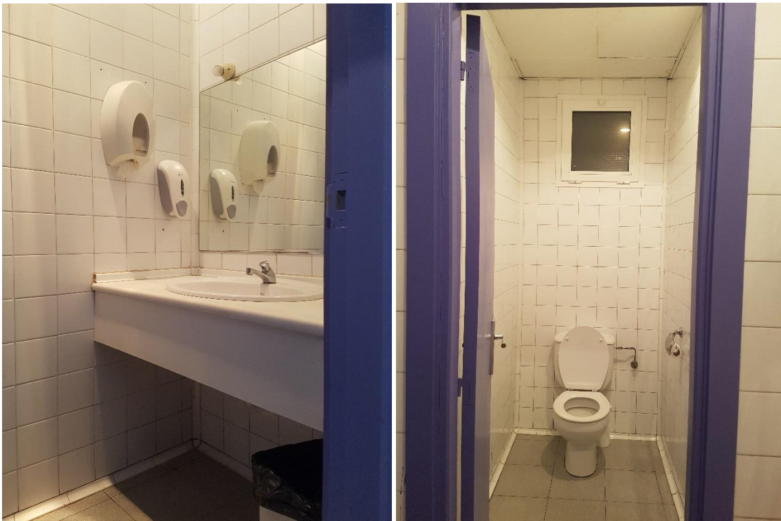
VISTAS PASILLO LLEGADA A BAÑOS Y BAÑOS PLANTA BAJA.
