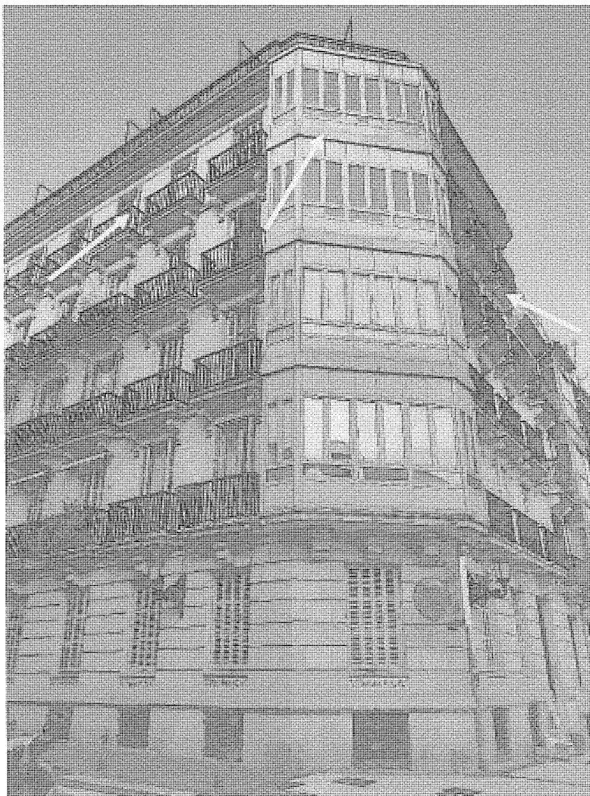
FOTO DE FACHADA
