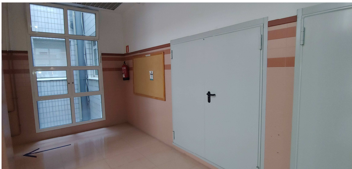
Fig. 2- Zona apertura del nuevo acceso
