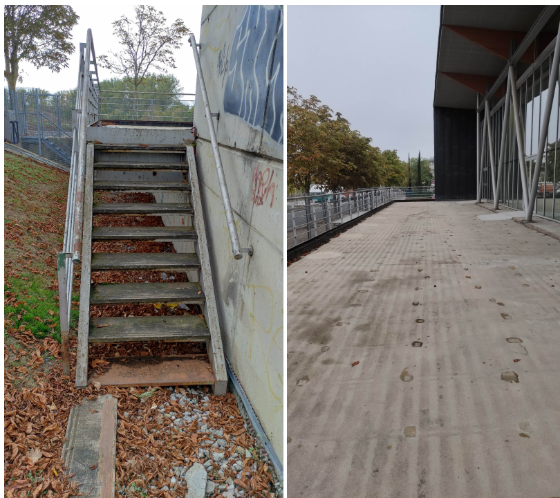
Peldaños a sustituir y terraza objeto de memoria
