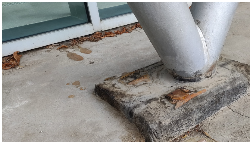
Encuentro de pilares a rematar con solado cerámico
