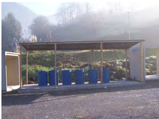
Punto limpio en construcción
