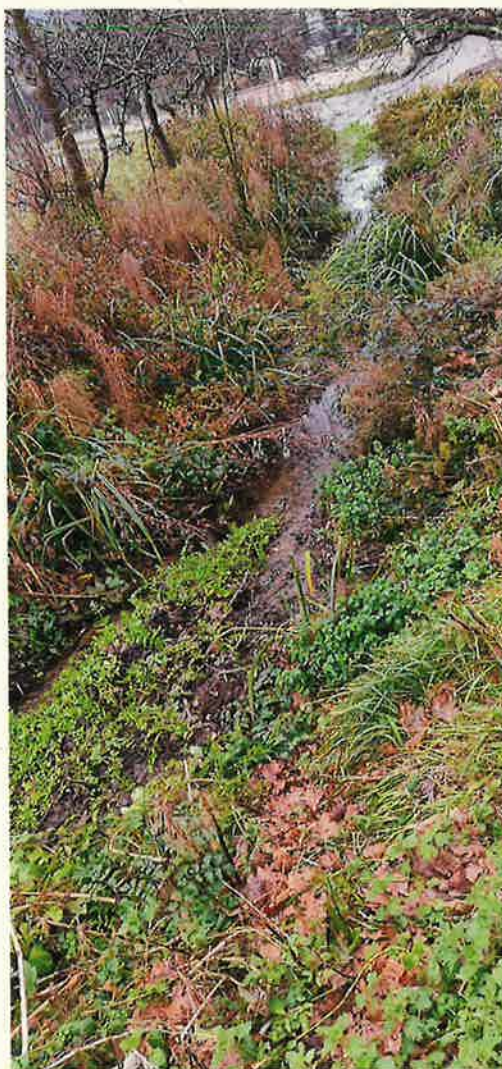
Vista del arroyo en la zona donde se desbordó, dañando y colapsando las acometidas de pluviales.
