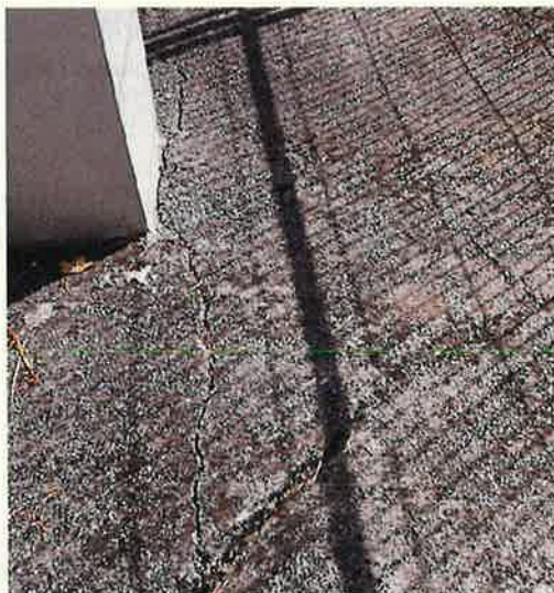
Vista de la solera sobre la escollera en la parte trasera de la pared lateral del frontón.
