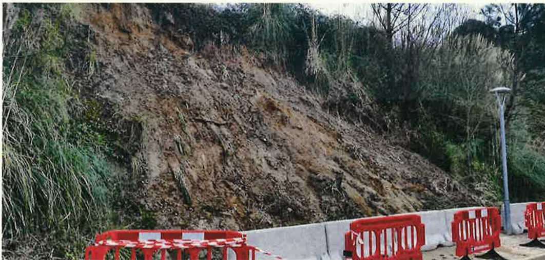
Fotografía de la parte baja del talud, junto al vial
