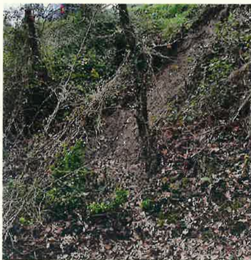
Fotografía del deslizamiento sufrido.
