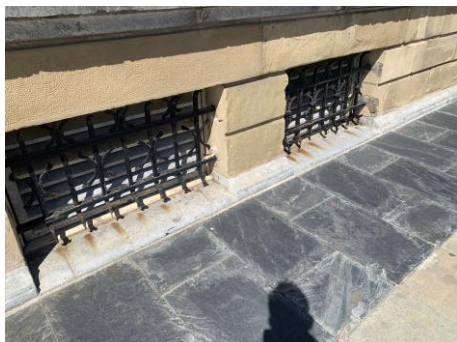
Fotos. Bajante oxidación rejas y degradación sillares.
