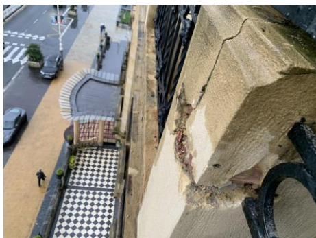
Fotos. Barandillas y pilastras de planta 4ª
