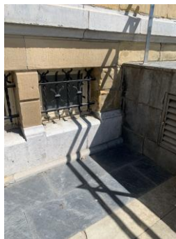
Fotos. Bajante oxidación rejas y degradación sillares.
