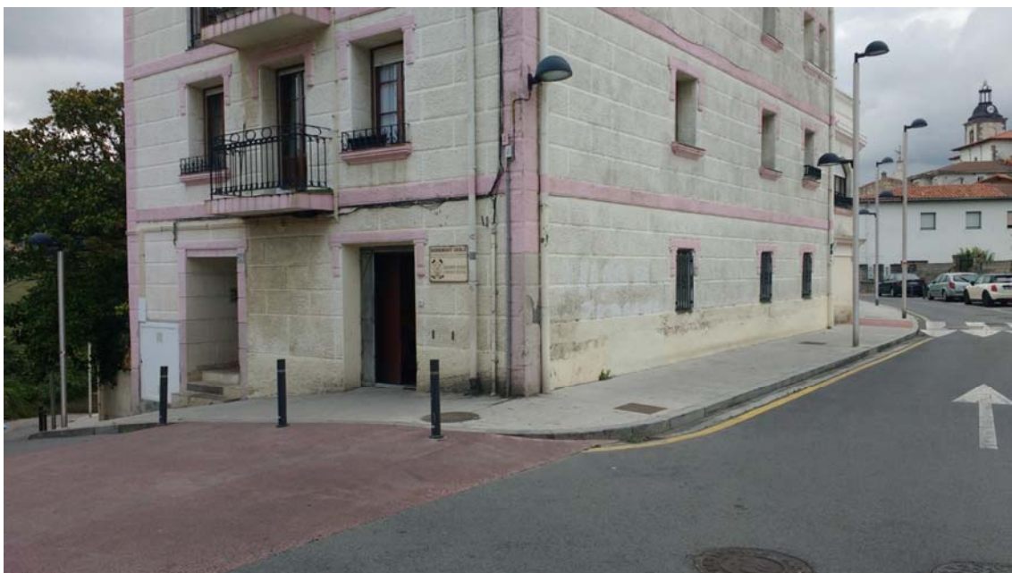
FOTO 02: Vista general exterior (acceso calle Norte)
