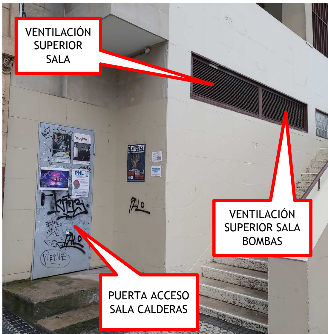
(Imagen de la ventilación superior y de la puerta de acceso en la Sala de Calderas)
