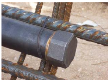
Tubería metálica para ensayos en jaula de armadura, en esta caso fijada mediante amarre con latiguillo
