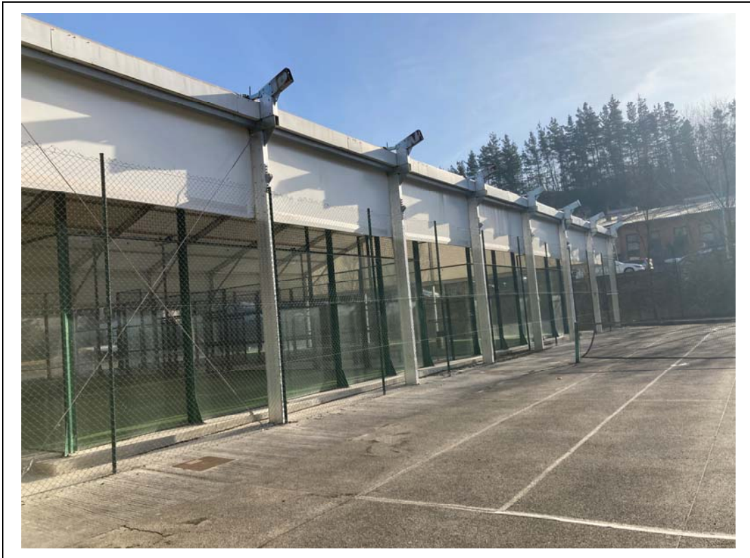
Vista de la carpa existente en las pistas de pádel
