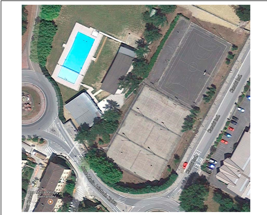
Vista aérea del conjunto de la zona deportiva anterior a la instalación de las cubriciones.
