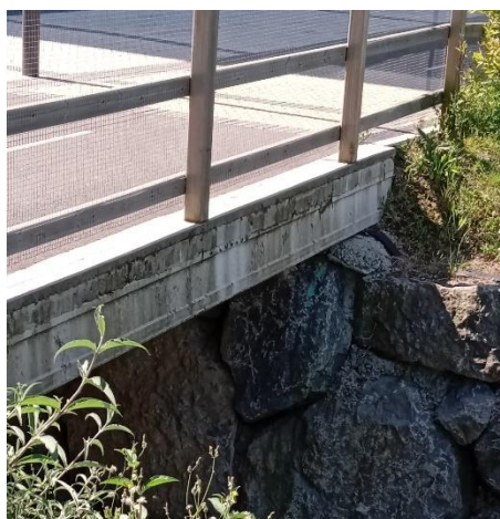
Imagen: lateral del puente
