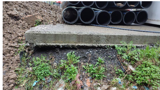
Losa de pavimentación actual
